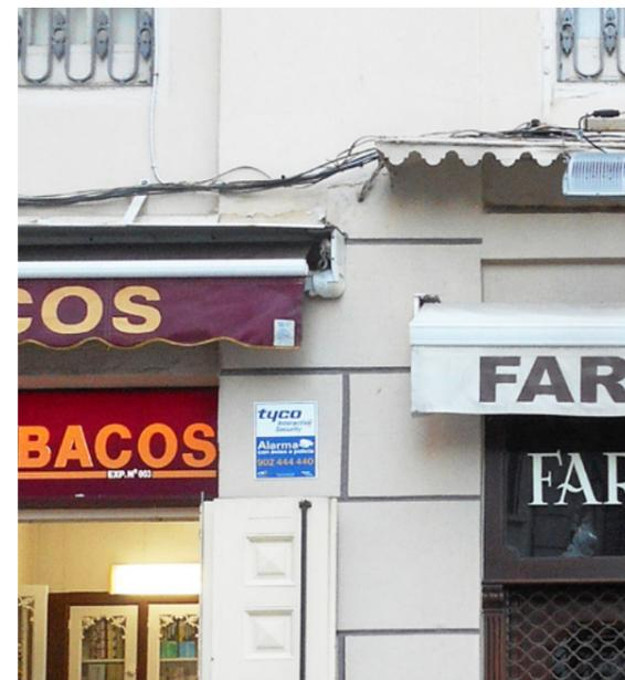
✗ Anclaje de toldo sobre paramento de fachada, no se adapta al hueco.
