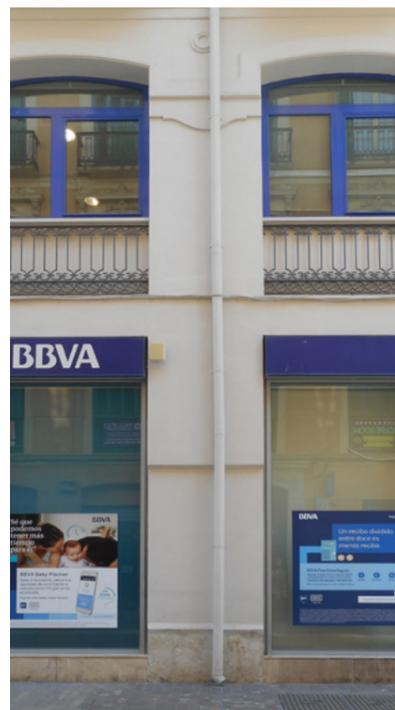
✓ Bajante tradicional del siglo XIX, metálico, visto hasta planta baja pasando por delante del zócalo.
