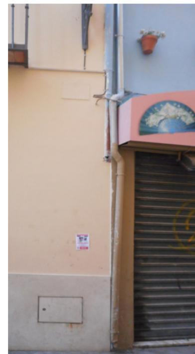
✗ Bajante metálico, visto en planta baja y meando a la calle.
