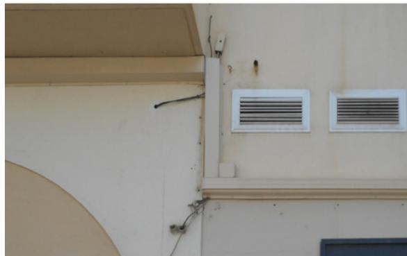
✓ Canalización de cableado con canaleta respetando el cromatismo de fachada.
