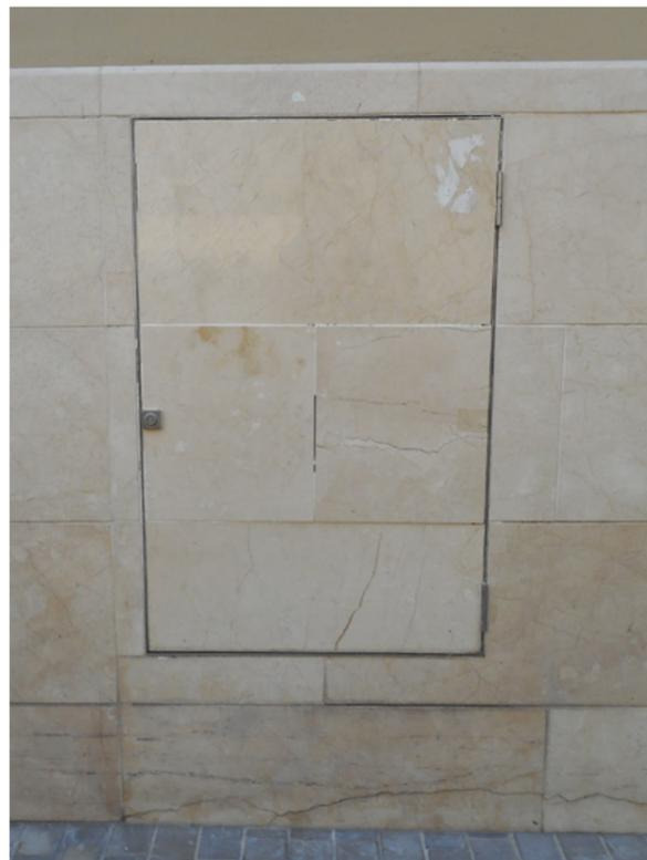
✓ Tapas de contadores integradas en el zócalo de la fachada.
