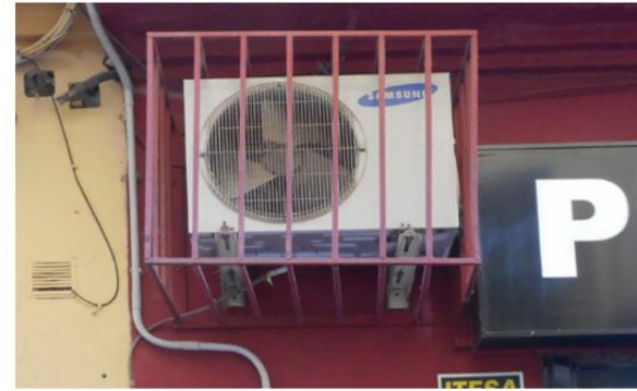
✗ Compresor de aire acondicionado sobre paramento exterior con reja protectora.
