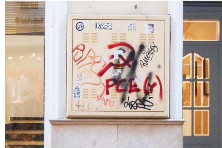
✘ Contador fuera del plano de fachada, no integrado con la fachada y con falta de adecentamiento.
