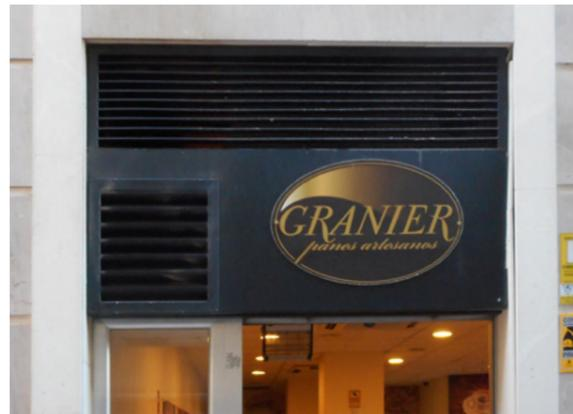
✓ Rejilla mixta para conductos de ventilación y extracción de humos, colocados en hueco de fachada ante la imposibilidad de llevarlos a cubierta.
