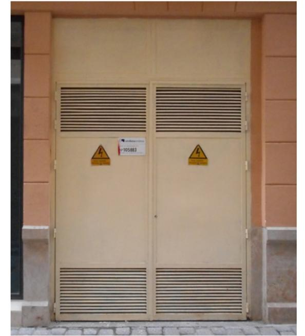
✗ Puertas de centro de transformación en hueco incumpliendo las reglas de composición arquitectónica estudiadas en esta guía, anchura, altura, alineación, etc.
