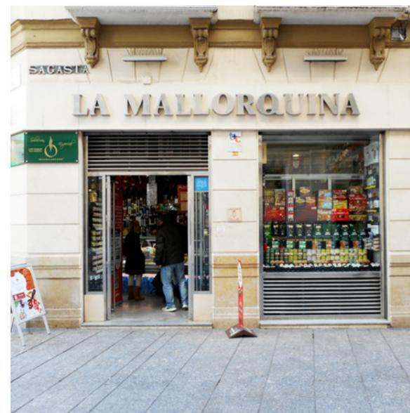
✓ Rejilla de ventilación integrada en la carpintería sin sobresalir de su plano. En la parte superior para ventilación del local y en la parte inferior para ventilación de los motores de las vitrinas.
