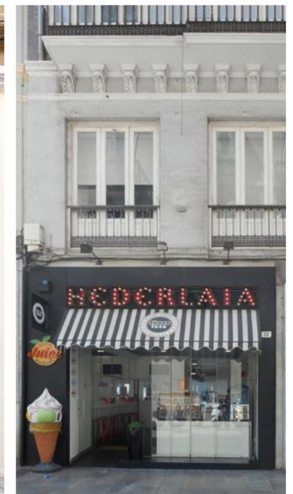
✗ El revestimiento no respeta el diseño original de la fachada.
