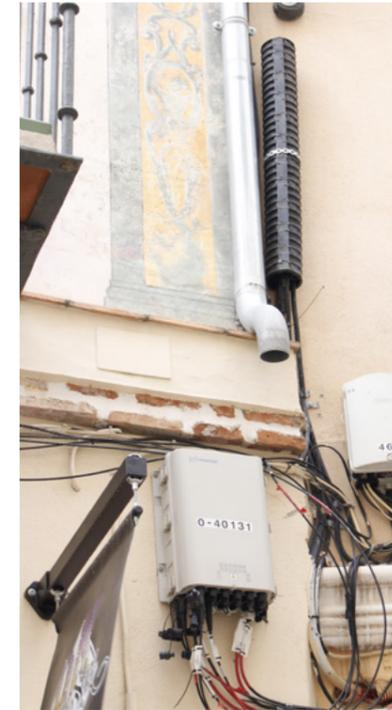
✗ Bajante de zinc, cortado en planta primera y meando sobre cableado.
