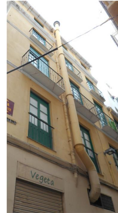
✗ Mala ejecución de conducto de extracción de humos conducido hasta cubierta por fachada.
