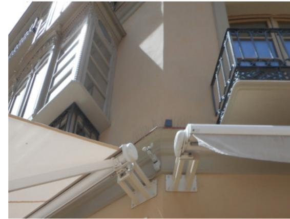
✗ Anclaje de toldo sobre paramento de fachada, no se adapta al hueco.
