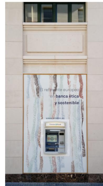
✗ En el caso de cajero en el ámbito del hueco, éste debe respetar el retranqueo de los huecos en fachada. Izquierda, alineado al plano de fachada (mal); derecha, respetando el retranqueo (bien).
