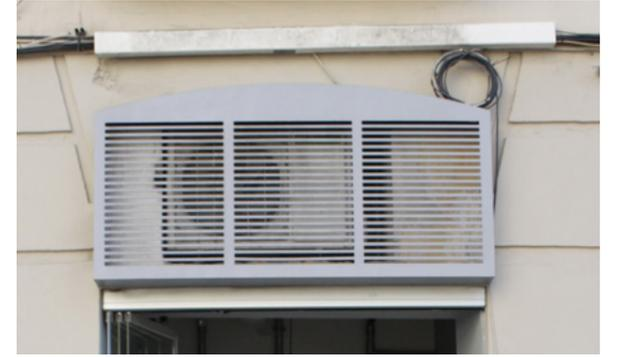
✗ Compresor de aire acondicionado colocado tras rejilla de ventilación sobresaliente del plano de fachada y con demasiada transparencia dejándolo al descubierto.
