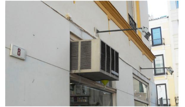
✗ Compresor de aire acondicionado en hueco que sobresale del plano de fachada.
