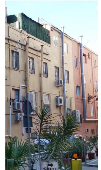
✗ Mala ejecución de conducto de extracción de humos llevado hasta cubierta por fachada.
