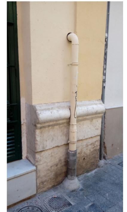
✗ El zócalo original es dañado para incorporar un elemento de instalaciones.
