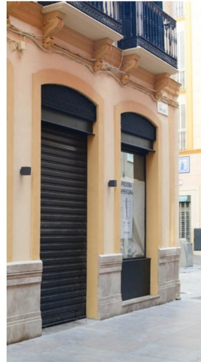
✓ El plano en el que se sitúan las carpinterías en el hueco está retranqueado con respecto al plano de fachada. Y la estructura preexistente (vigas) se integra con estas.
