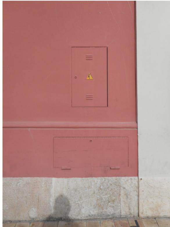
✓ Tapas de contadores integradas en el paramento de la fachada.
