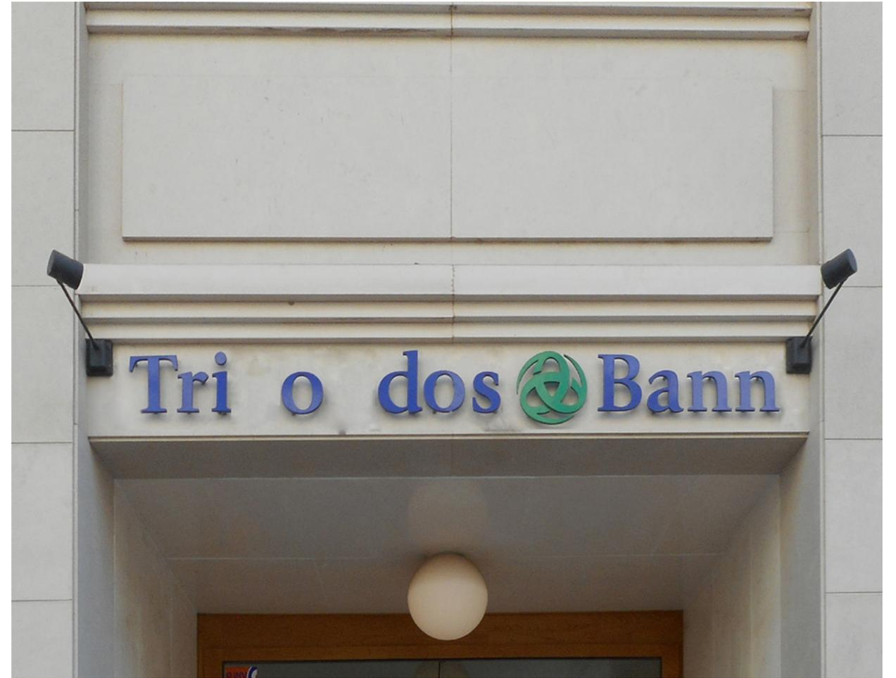
✗ Focos sobresalientes del plano de fachada anclados sobre dintel del hueco.
