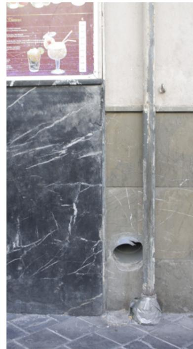
✗ El zócalo se rompe para incorporar un elemento de evacuación de pluviales hacia la vía pública, lo cual no está permitido.
