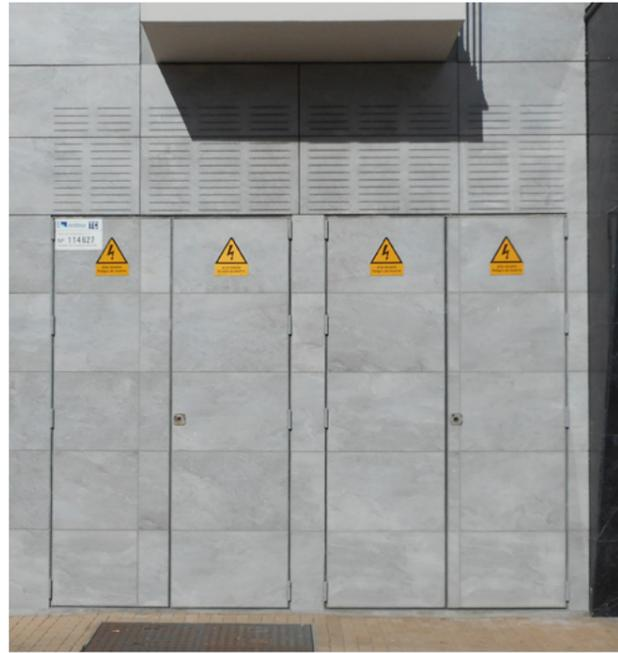
✓ Puertas de centro de transformación integradas en el paramento de fachada.
