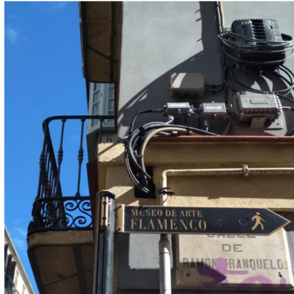
✓ Canalización de cableado tras línea de imposta. Falta de integración de los registros.
