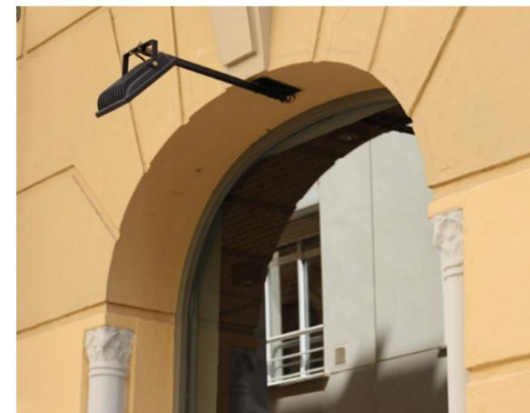
✗ Foco sobresaliente del plano de fachada anclado en la clave del arco.
