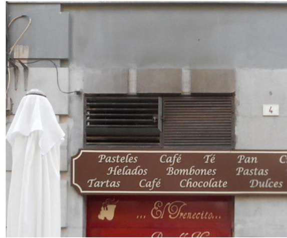
✓ Rejilla mixta para conductos de ventilación y extracción de humos, colocados en hueco de fachada ante la imposibilidad de llevarlos a cubierta.
