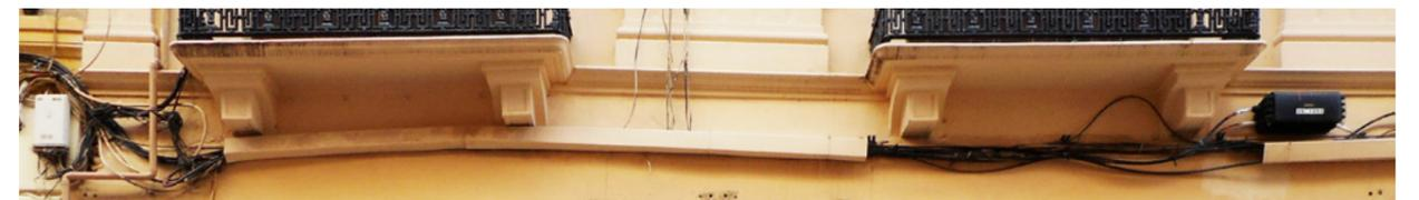
✗ Canalización de cableado mal ejecutada y mantenida.
