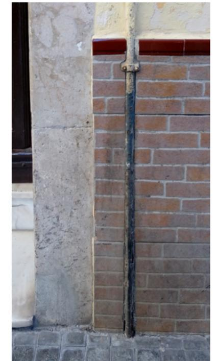
✗ El zócalo alicatado, interrumpido por el paso de un tubo de instalaciones.
