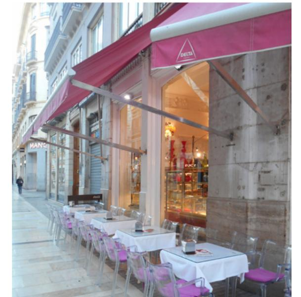
✗ Anclaje de toldo sobre pilastra de fachada, no se adapta al hueco.
