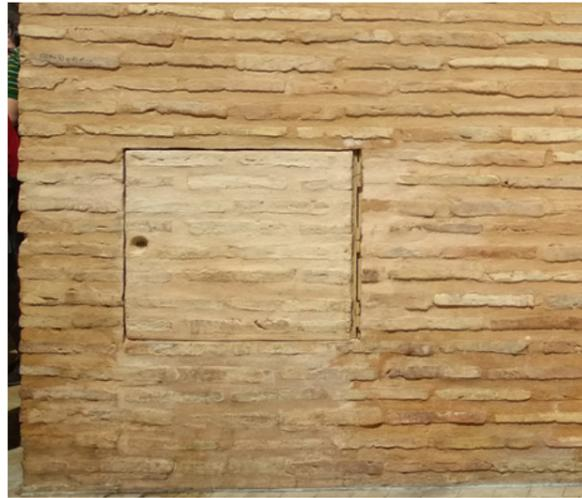
✔ Tapa de contador integrada con la fachada.
