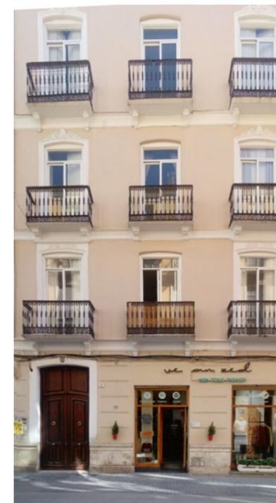
✗ Los huecos de la derecha no respetan la altura original de los huecos de la planta baja.
