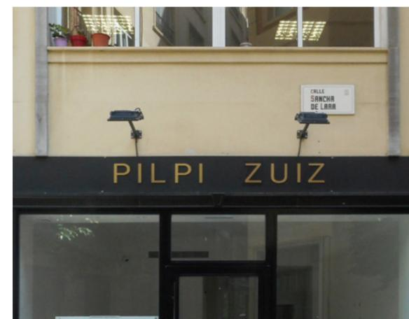
☒ Focos sobresalientes del plano de fachada anclados sobre el paramento.
