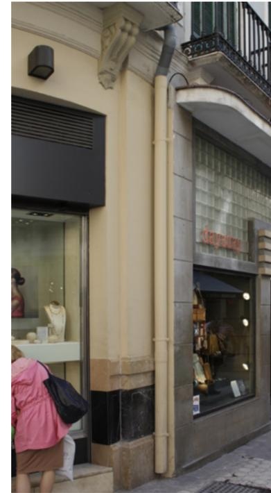
✗ Bajante de PVC, visto en planta baja y meando a la calle.
