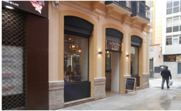
✓ Rejilla de ventilación integrada en la carpintería sin sobresalir de su plano adaptándose en diseño, material y color e integrándose con la estructura preexistente.
