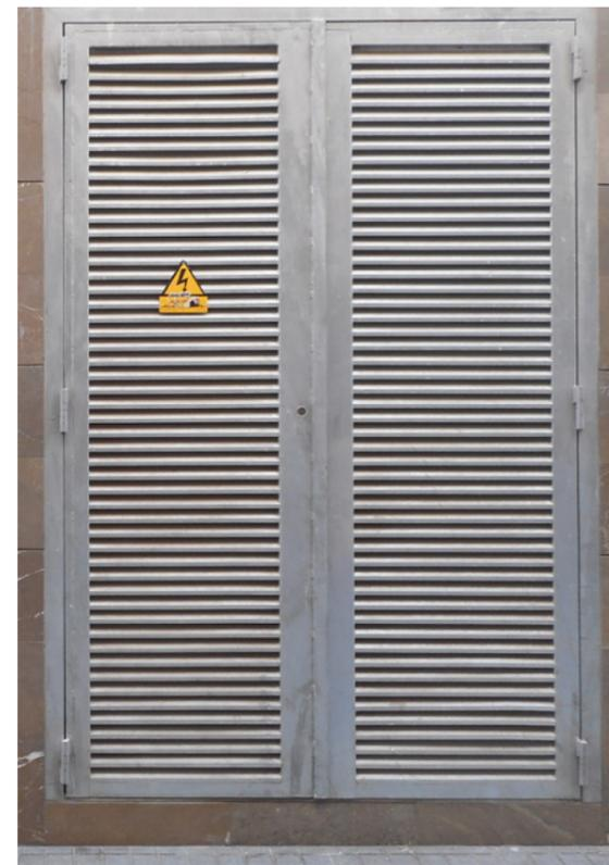
✗ Puertas de centro de transformación no integradas en el paramento de fachada.
