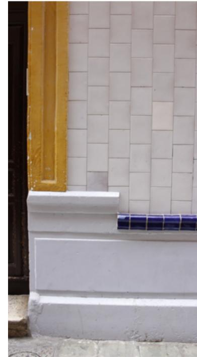
✗ La altura del zócalo disminuye a mitad de la pieza, produciendo un corte en el elemento original.
