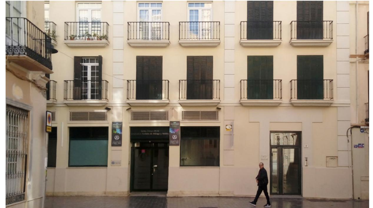
✘ El ritmo de la fachada se rompe en la planta de locales al no respetar los ejes que marcan los huecos superiores.
