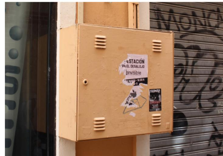
✘ Contador fuera del plano de fachada afectando a paramentos y recercado de huecos.
