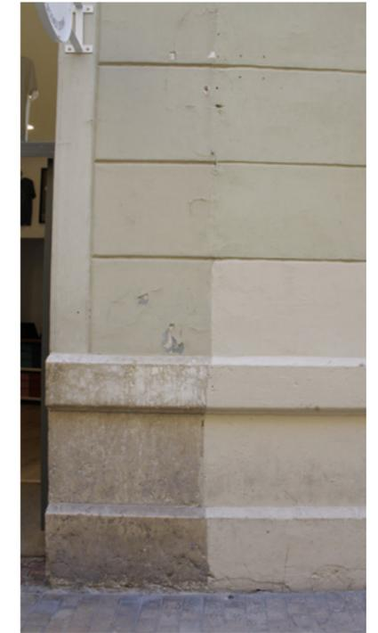
✗ El acabado original del zócalo se ve modificado al pintar parte de la pieza.
