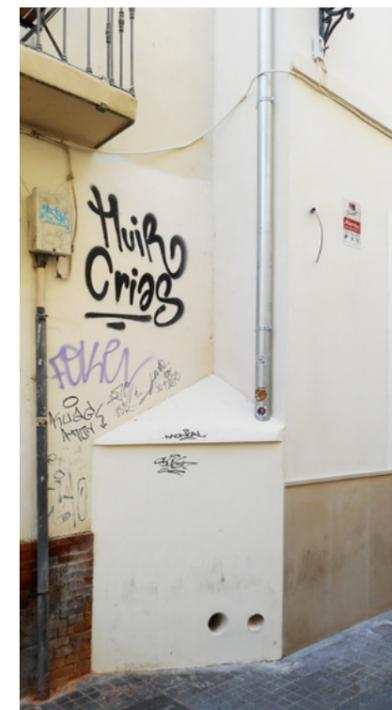
✗ Bajante de pluviales metálica visto en planta baja y meando a la calle.
