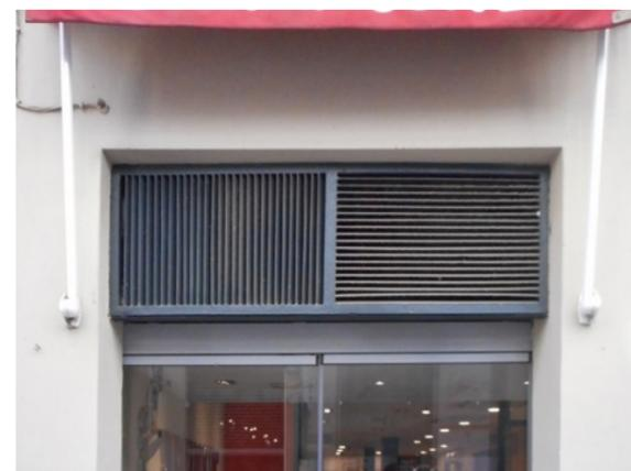
✓ Rejilla mixta para conductos de ventilación y extracción de humos, colocados en hueco de fachada ante la imposibilidad de llevarlos a cubierta.
