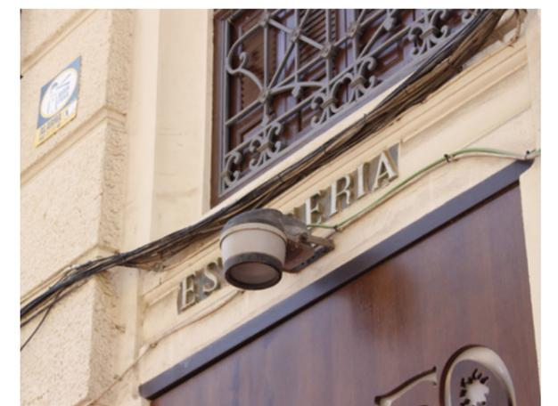
☒ Foco sobresaliente del plano de fachada anclado sobre el paramento.
