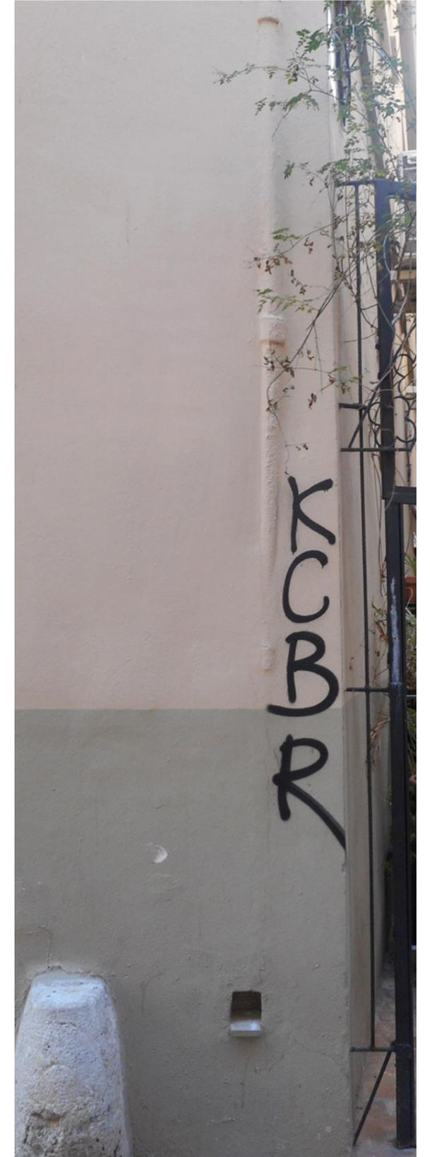
✗ Bajante de pluviales mal embutido dentro del paramento en planta baja y meando a la calle.
