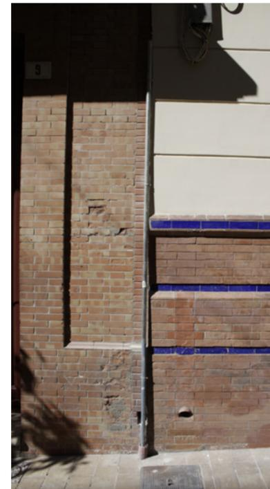
✗ El zócalo de ladrillo se rompe para incorporar un elemento de evacuación de pluviales hacia la vía pública, que no está permitido.
