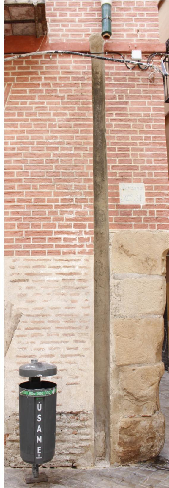
✗ Ejecución de roza para encastrar la bajante de pluviales tradicional en planta baja, quedando vista solo hasta planta primera.
