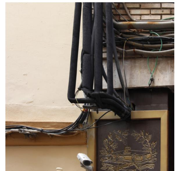
✗ Elementos de conexión entre unidad exterior y unidad interior de la climatización vistos en la fachada.
