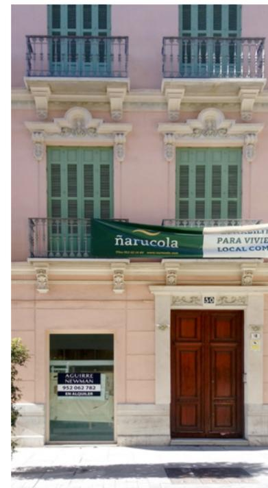
✗ El hueco de la izquierda tiene alterada la altura original
