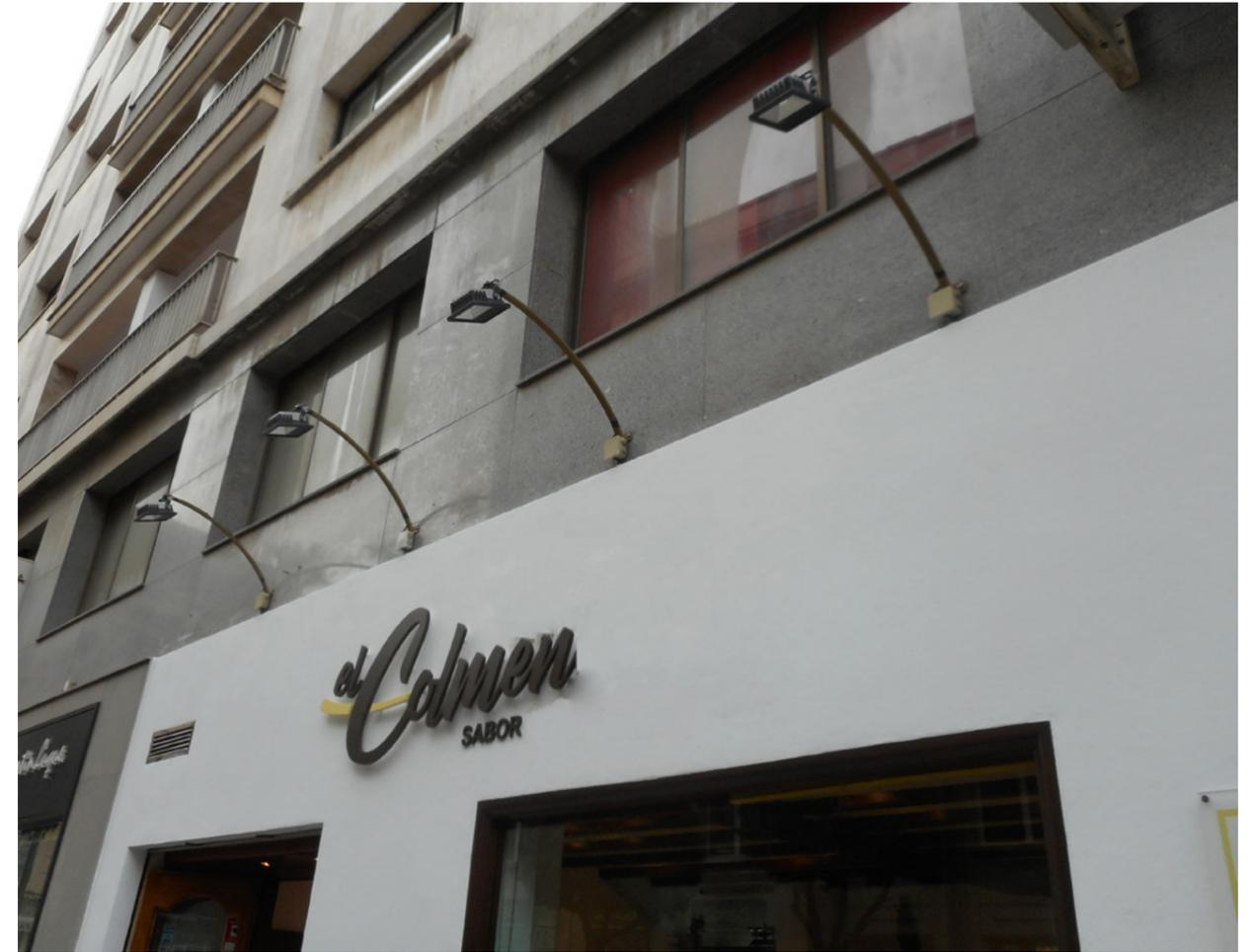
✗ Focos en línea sobresalientes del plano de fachada anclados sobre el paramento.
