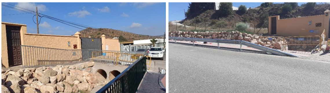
Ilustración 4: Obras de drenajes, Acerados nuevos y bionda
