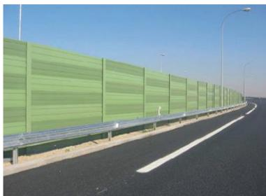
Figura 28: Metálica absorbente
