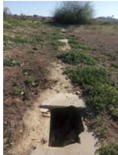
**Ilustración 6: Imagen en la que se aprecia el tratamiento de hormigón para la ejecución de la canalización.**
