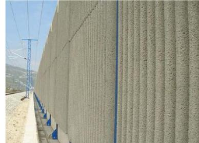
Figura 30: Hormigón poroso
