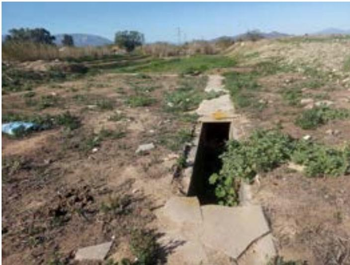
**Ilustración 5: Imagen de canalización con relleno de escombros.**
