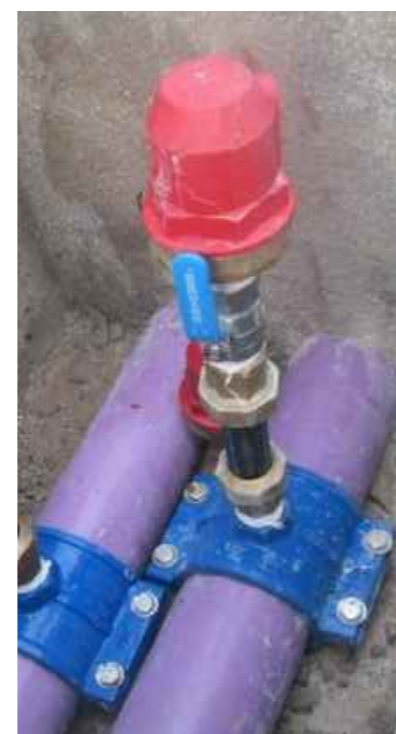
DETALLE VENTOSA ESCALA: S/E
