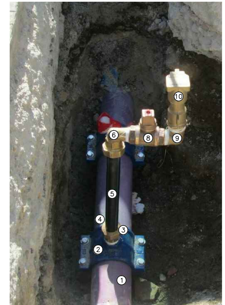
DETALLE PICA ESCALA: S/E
