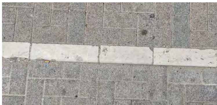
DETALLE DE ACERADO Y VIA DE CIRCULACION DE CALLE TRINIDAD
