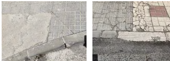
DETALLE DE ACERADO Y VIA DE CIRCULACION DE CALLE TRINIDAD
