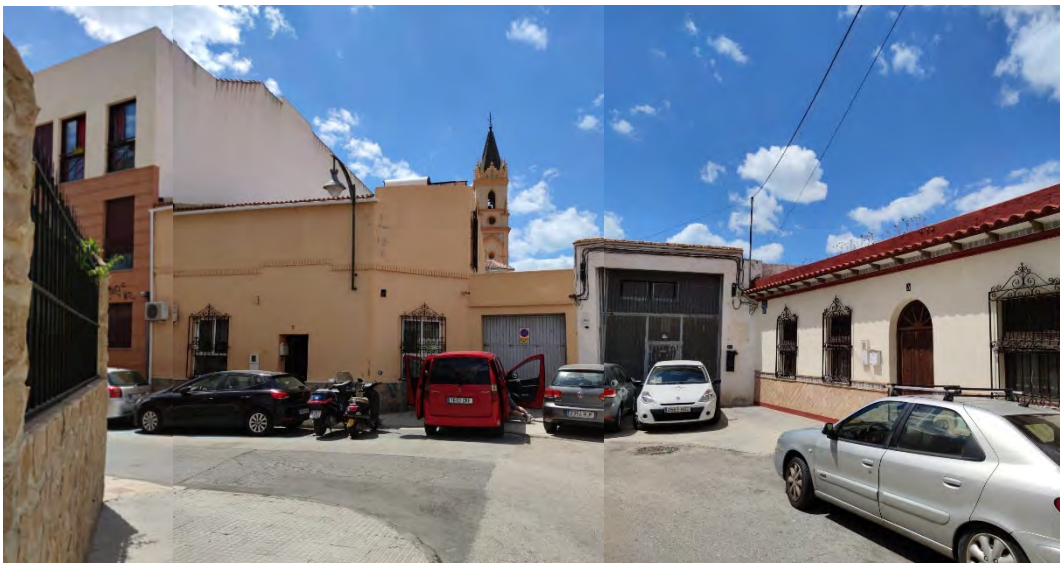
VISTA DE LA ZONA DE CONEXIÓN DEL NUEVO VIAL EN LA ESQUINA DE CALLE JUAN DE HERRERA Y QUIQUISOLA CON LA CALLE TRINIDAD
