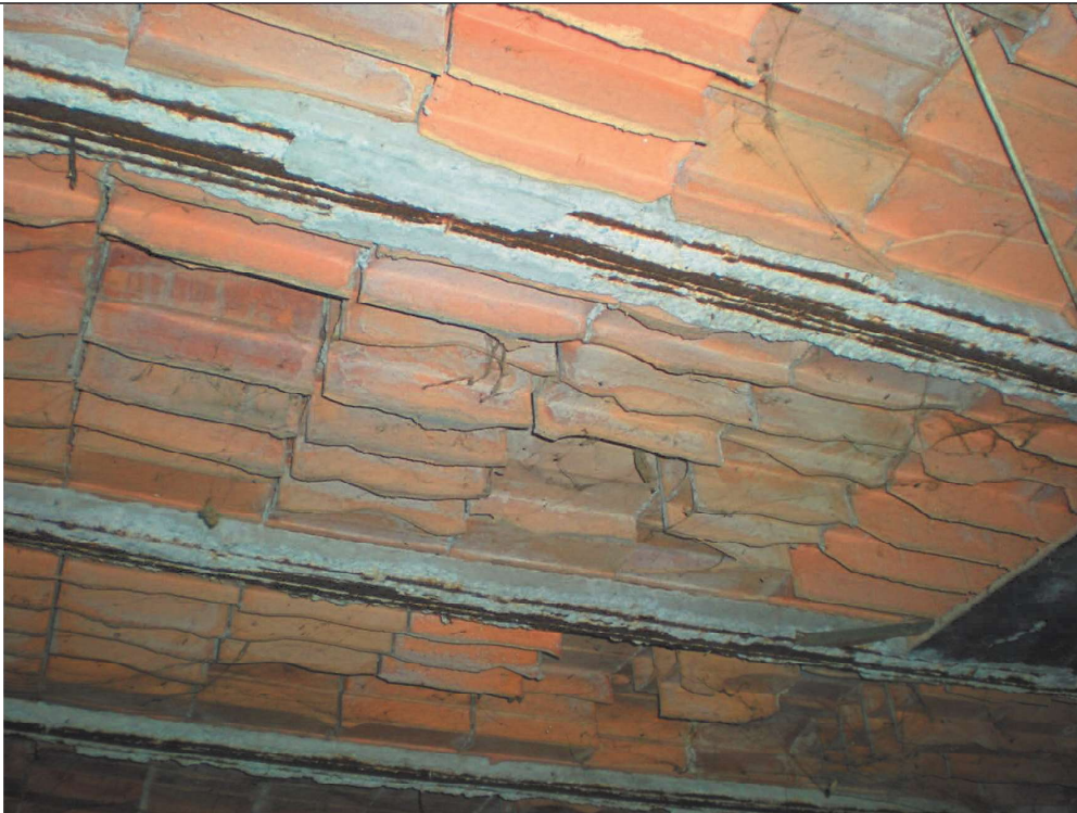
Detalle estado de forjado
