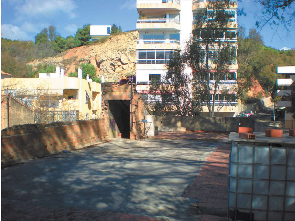
Azotea. Vista hacia avenida Pintor Joaquín Sorolla
