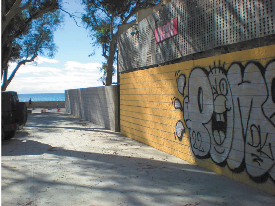
Detalle cerramiento muro de bloque de hormigón
