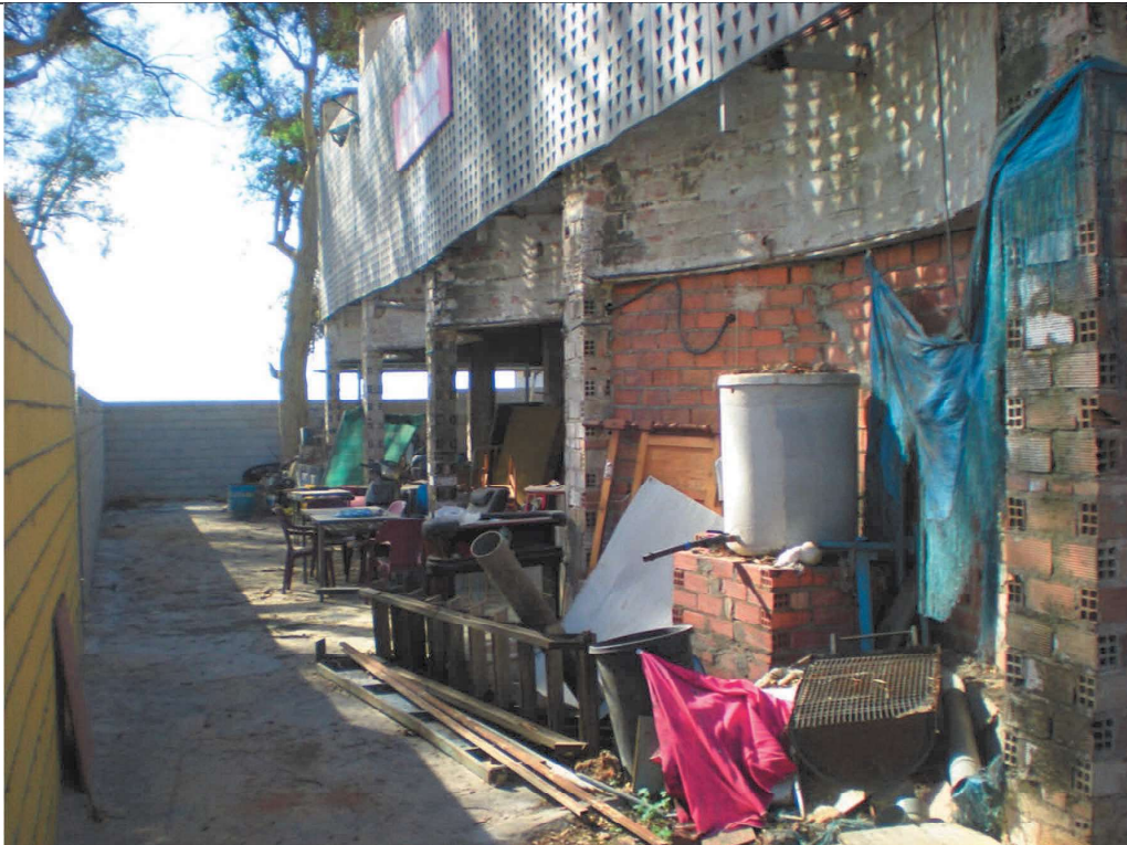
Vista de la estructura desde el interior de la parcela hacia el Sur
