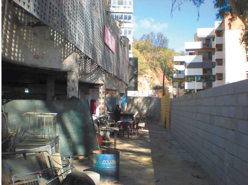
Vista de la estructura desde el interior de la parcela hacia el Norte
