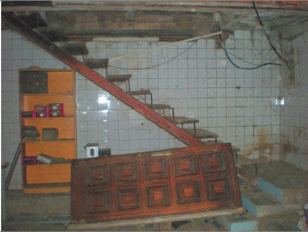
Escalera bajada a sótano
