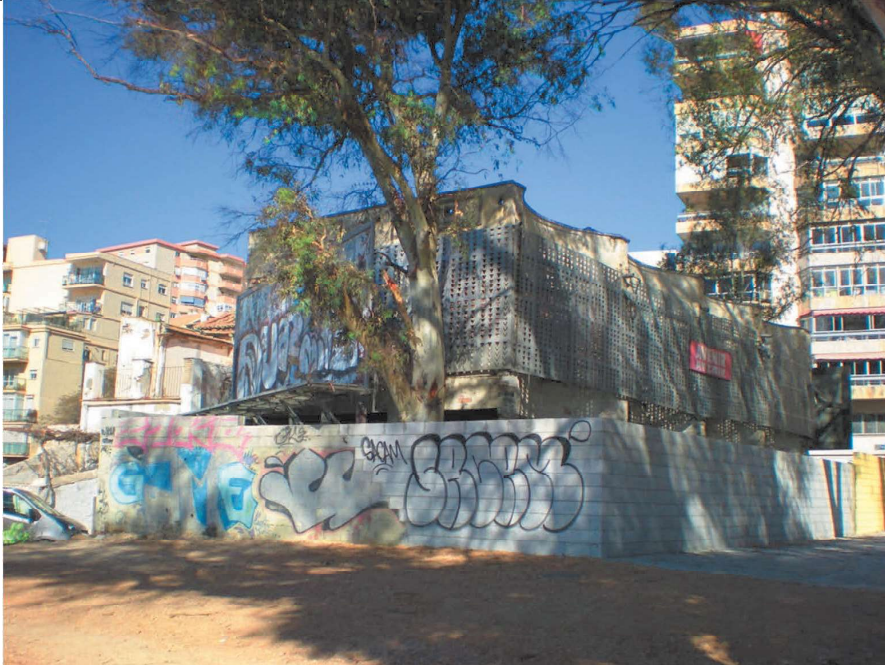
Vista general desde calle Bolivia.
