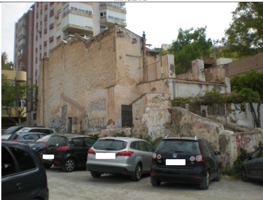
Vista general desde calle Bolivia (fachada trasera y medianera Oeste) (17/06/2022)
