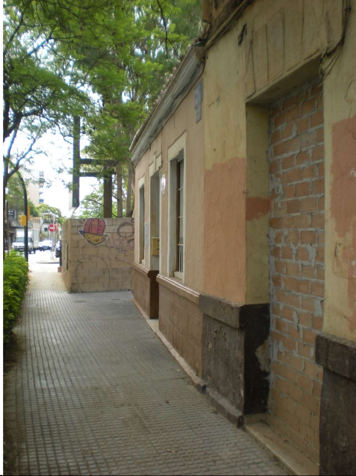
Alineacion de fachada a avenida Pintor Joaquín Sorolla (17/06/2022)
