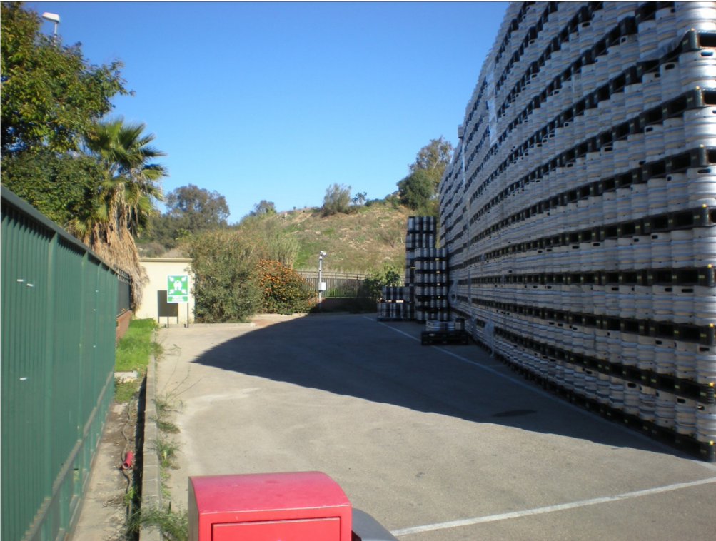
Pavimento bituminoso y cerramiento interior a calle Mercadante (26-01-2023)
