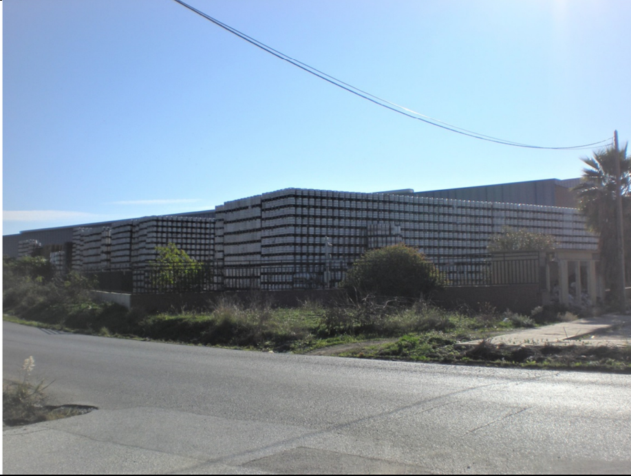
Vista general desde Camino Santa Inés (26-01-2023)
