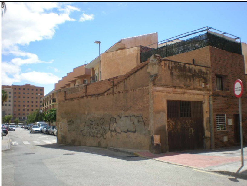
Fachada principal a calle Pulgar y lateral a calle Edward Elgar (24/05/2023)
