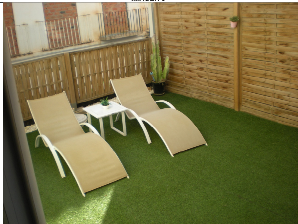
Cubierta del inmueble con uso de terraza visitable con acceso desde la vivienda 1º centro del inmueble colindante de calle Álvarez nº 13 (06/03/2024)
