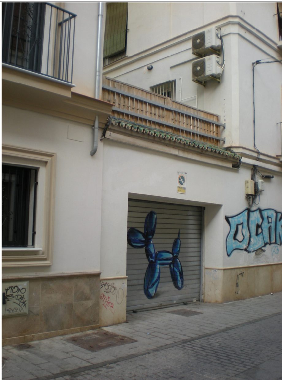
Fachada a calle Álvarez (12/02/2024)
