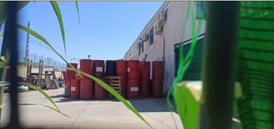
Vista de la zona posterior de la nave desde el Oeste (23/04/2025)
