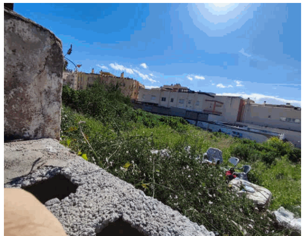
Interior.Vista general del suelo
