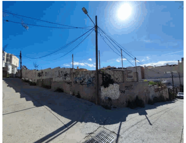
Interior.Vista general del suelo
