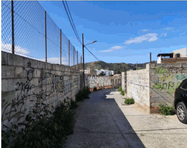
Interior.Vista general del suelo
