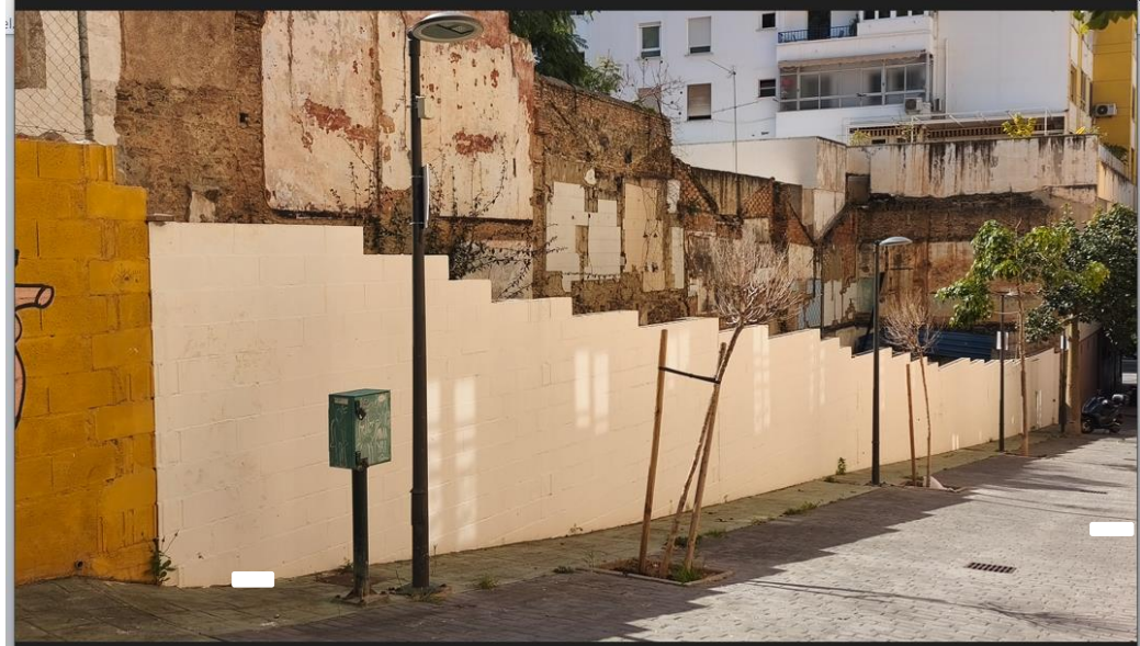
Vista general desde Calle Picacho (24/03/2026)
