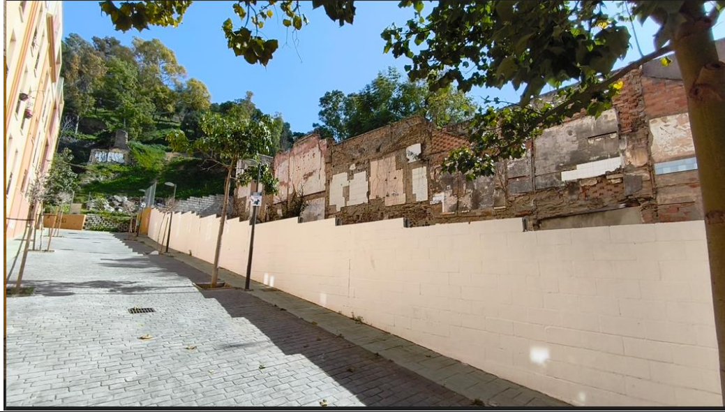
Vista general desde Calle Picacho (24/03/2026)
