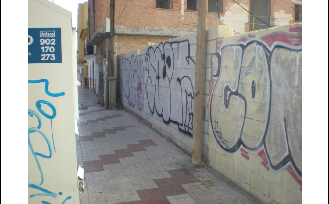
Fachada a calle Martínez de la Rosa (19/02/2025)
