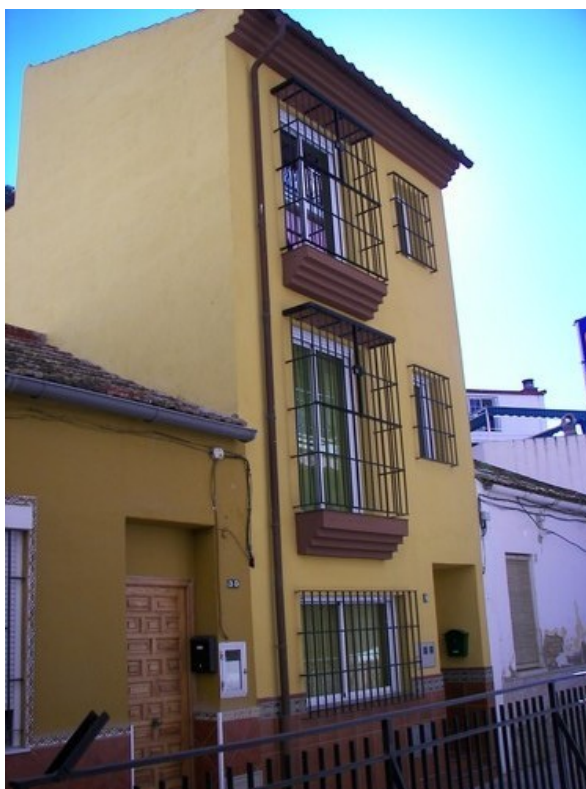
Fig. 16 - Foto de fachada de vivienda en Bachiller Sansón Carrasco nº 8 en la que se observa que la alineación histórica no tiene retranqueos (se puede ver a los laterales de la vivienda situada en el nº 8 las viviendas antiguas y que todas ellas están alineadas al vial). Fuente: Sede Electrónica del Catastro.
