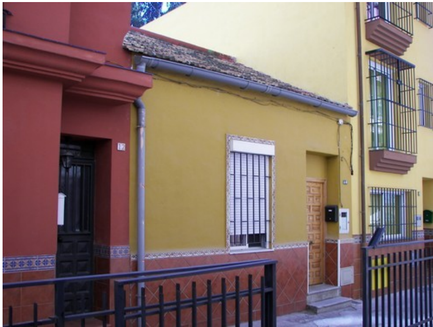
Fig. 17 - Foto de fachada de vivienda en Bachiller Sansón Carrasco nº 10 en la que se observa que la alineación histórica no tiene retranqueos. Fuente: Sede Electrónica del Catastro
