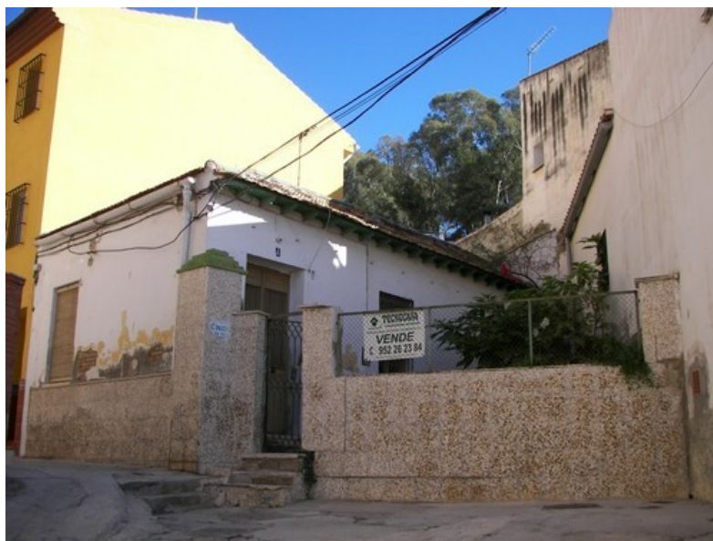
Fig. 15- Foto de fachada de vivienda en Bachiller Sansón Carrasco nº 6 (antes de su demolición), en la que se observa que la alineación histórica no tiene retranqueos. Fuente: Sede Electrónica del Catastro.
