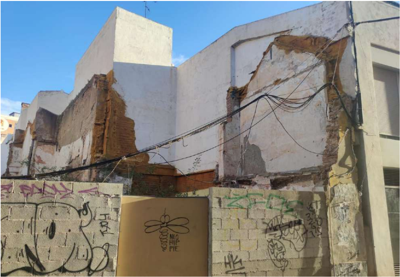
VISTA DE LA FACHADA DE LA PARCELA DE CALLE TRINIDAD NUMERO 17
