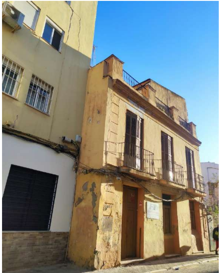
VISTA DE LA FACHADA DE LA PARCELA DE CALLE TRINIDAD NUMERO 13
