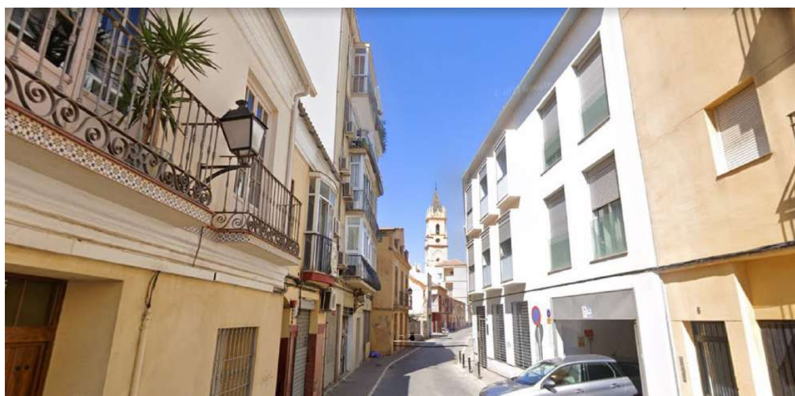
VISTA DE LA CALLE TRINIDAD DESDE LA ALTURA DEL NUMERO 9 DE CALLE TRINIDAD
