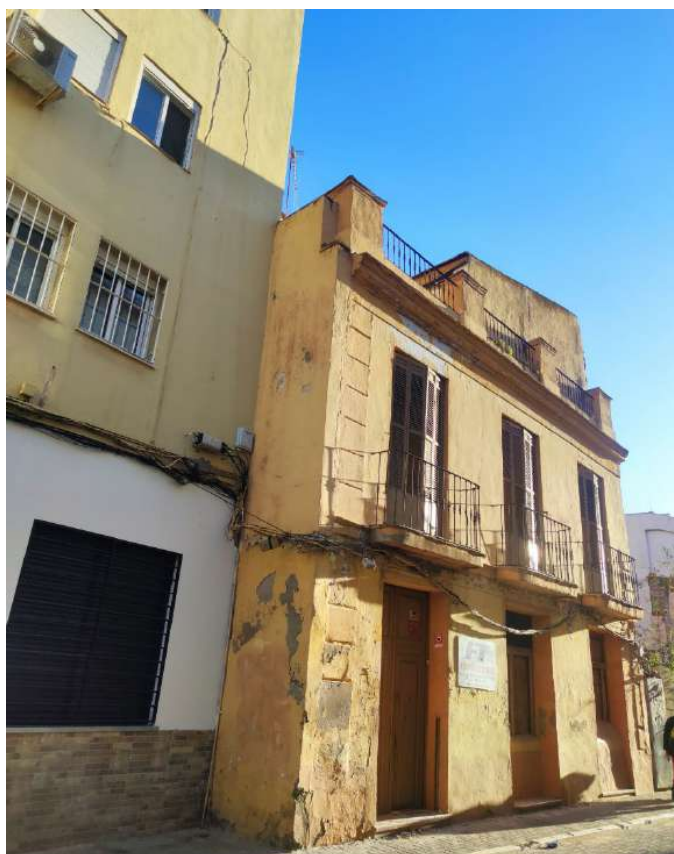
VISTA DE LA FACHADA DE LA PARCELA DE CALLE TRINIDAD NUMERO 13
