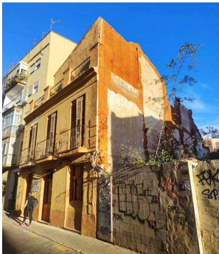
VISTA DE LA FACHADA DE LA PARCELA DE CALLE TRINIDAD NUMERO 13-15
