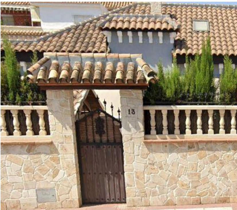
Detalle de fachada actual de la vivienda simétrica
