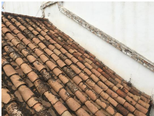
Cubierta inclinada con acabado original de teja árabe.
