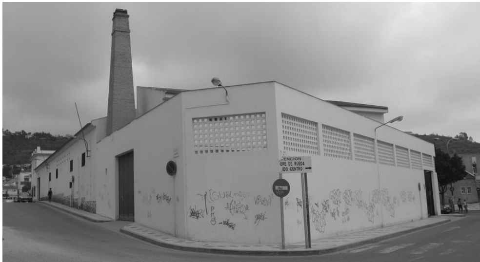
La chimenea en el entorno urbano desde la rotonda de calle Boccacio
