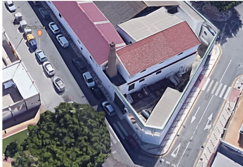
Vista aérea del estado actual de la chimenea.
