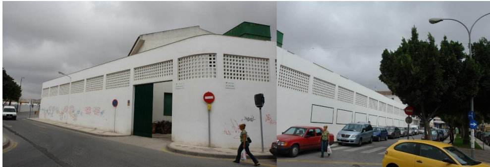
Vista de la almazara desde la Avda. Andersen
