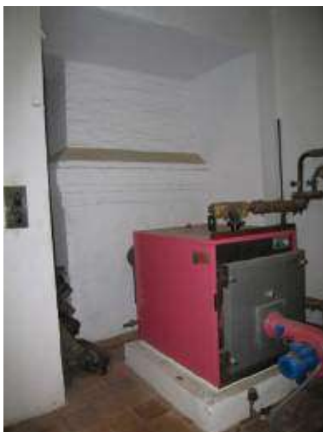
Imagen interior de la base, conectada a la salida de humos de un motor diesel.
