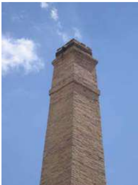
Vista del remate de la chimenea.
