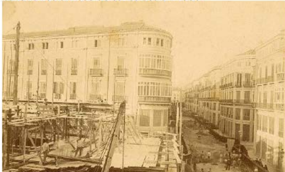
Calle Larios en fase de construcción 1880
