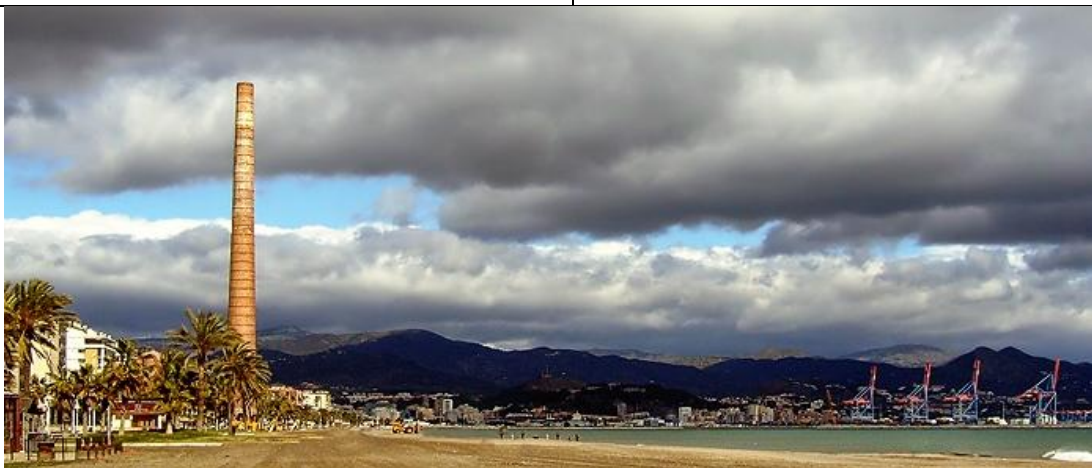
Estado actual, altura de la chimenea 96 m. Altura sobre el nivel del mar 105 m
