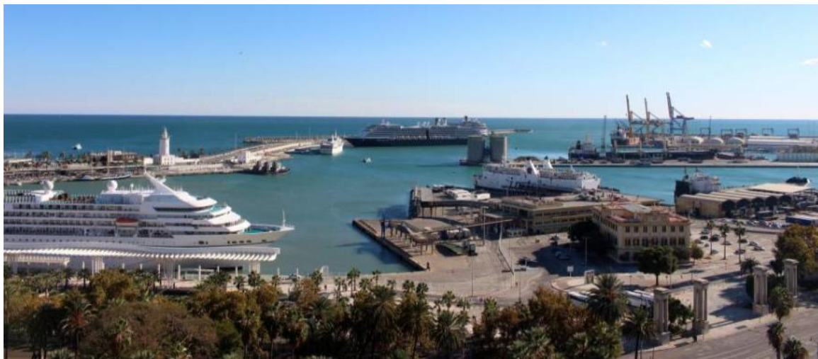
Fotografía del Puerto estado Actual, tránsito de cruceros, la farola (33 M) y las grúas existentes con una altura de 115 m
