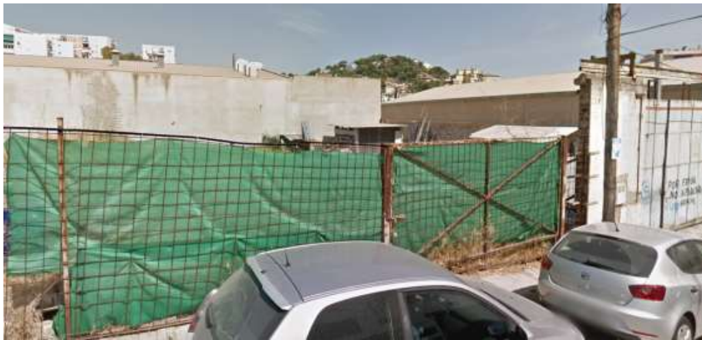
Figura 4: Zona prevista para la ejecución del acceso de salida a calle Potosí.
