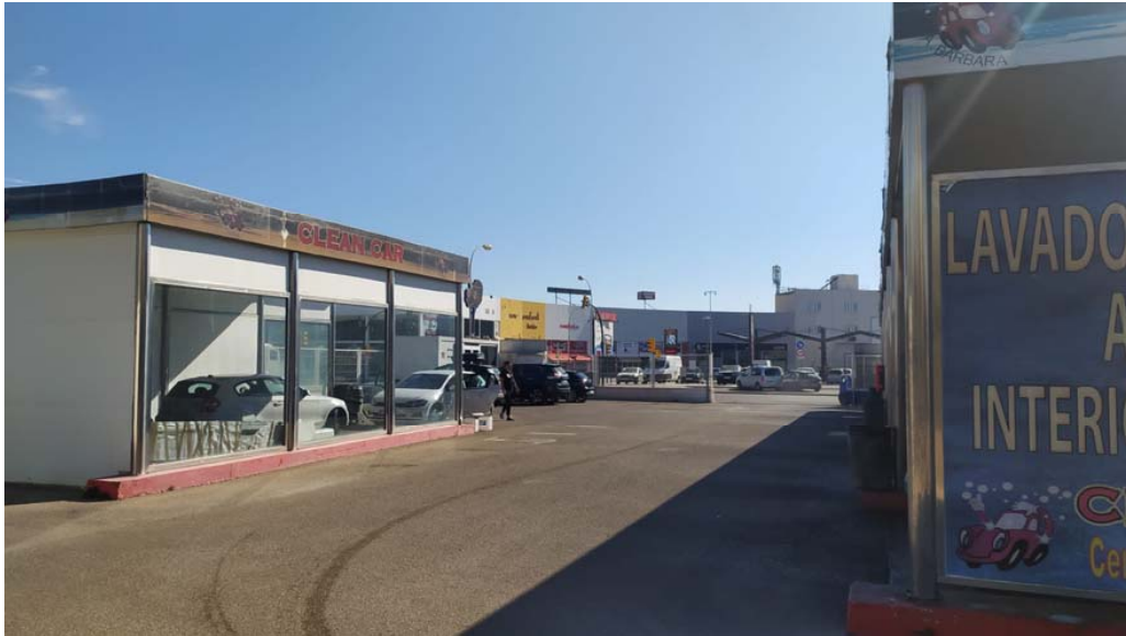
Túnel de lavado y aparcamientos
