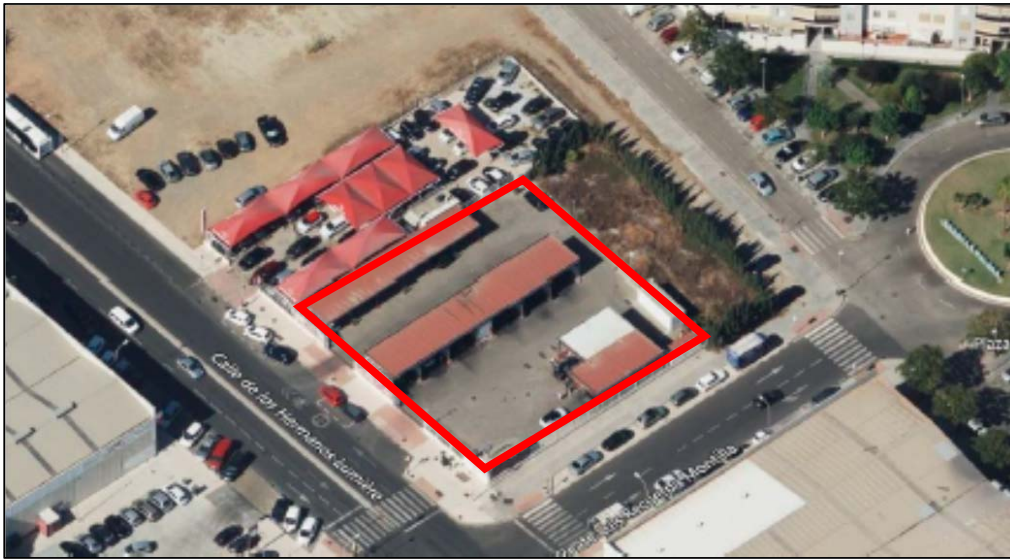
Vista aérea de la parcela en su situación actual
