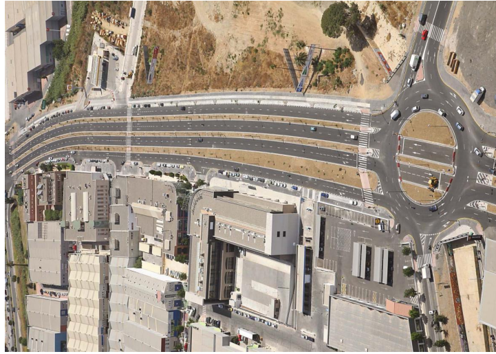
Figura 17. Vista de la adaptación de la Carretera de Cártama en el tramo: Glorieta María Zambrano-Campanillas
