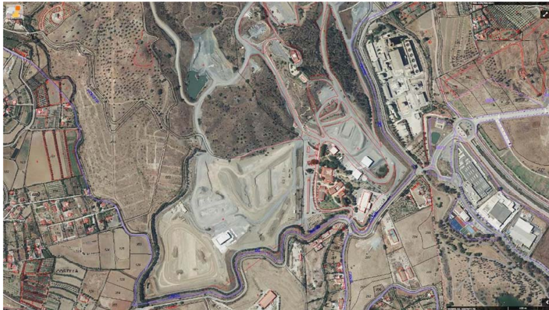
Vista parcial de edificaciones/instalaciones Caterpillar CF Málaga. Fuente ilustración I-7: Sede electrónica del Catastro SEC
