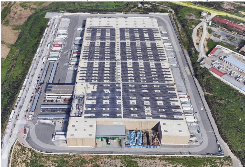
Ilustración 8. Paneles solares instalados en la cubierta del Centro Logístico LIDL.
