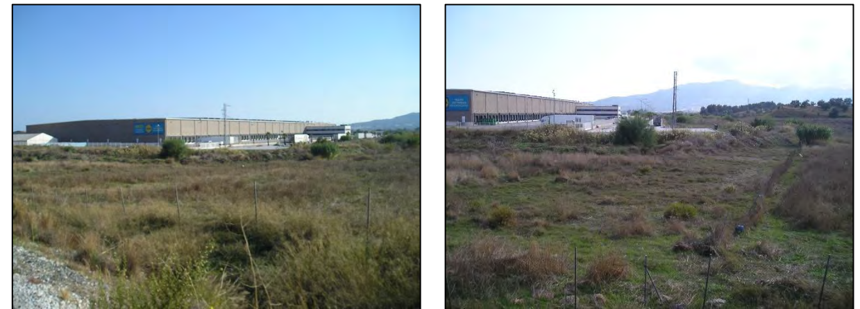
Instantánea 1: Vistas de la línea aérea en cuestión y torreta eléctrica para su paso a subterránea hacia las instalaciones logísticas.
