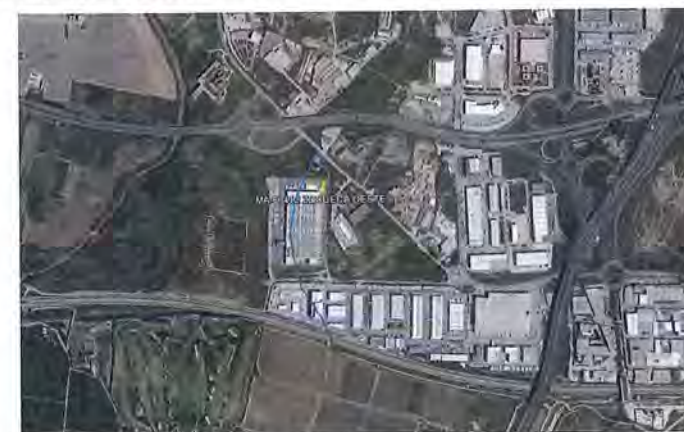
Ilustración 4: Ortofoto del sector, donde se muestra el trazado original del Arroyo Prado Jurado
