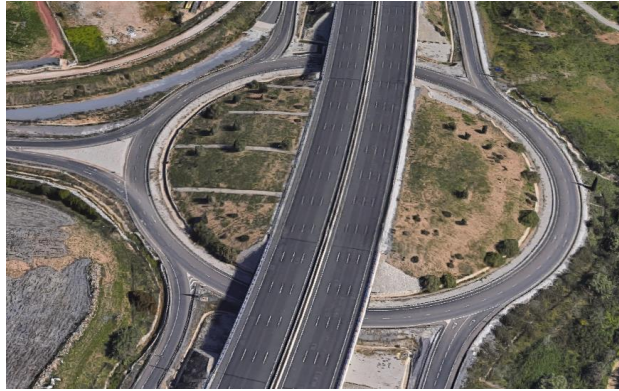
Ilustración 42. Vista aérea de la Glorieta bajo la Autovía A-7. Fuente: Google Maps.
