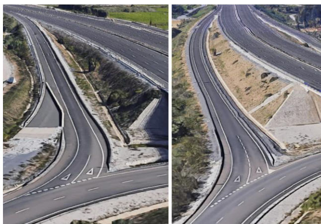
Ilustración 41. Vista aérea de las rampas de salida de la Autovía del Mediterráneo A-7. Fuente: Google Maps.
