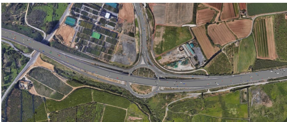
Ilustración 46. Imagen de la Glorieta Enlace A-7 y las rampas de acceso a la Autovía extraída desde el modelo.
