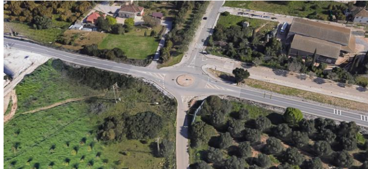
Ilustración 45. Vista aérea de la Glorieta de intersección entre la A-404, la C/ Vietnam y la C/ Argelia. Fuente: Google Maps.
