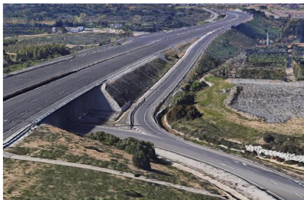
Ilustración 44. Vista aérea de las rampas de incorporación A-7 en dirección sur. Fuente: Google Maps.
