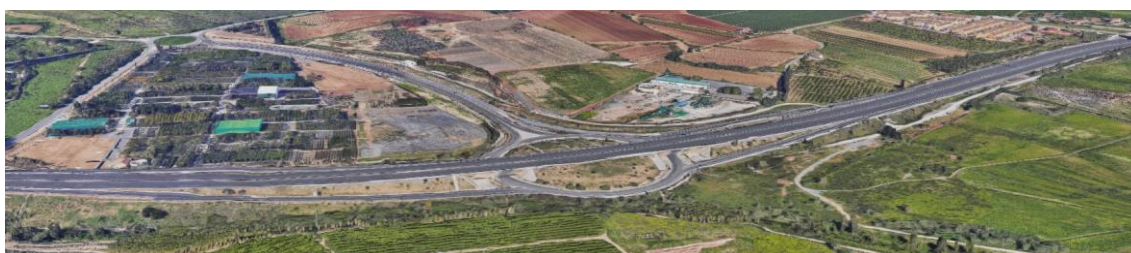
Ilustración 40. Vista aérea de la Autovía del Mediterráneo A-7 y la Glorieta enlace A-7. Fuente: Google Maps.
