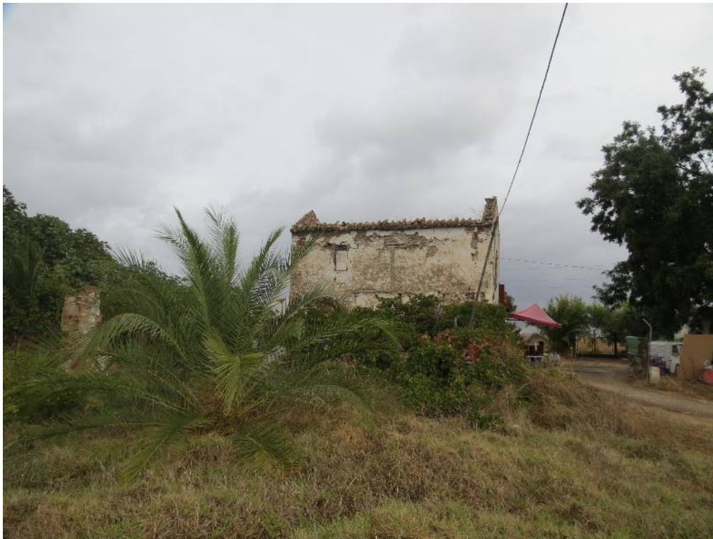
Edificación en ruinas.
