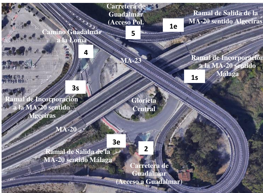
Ilustración 40. Accesos a Glorieta Central del Enlace (Pk. 3+000)
