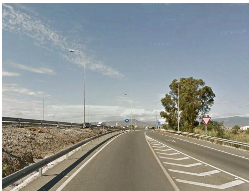
Ilustración 13. Confluencia con ramal de salida de la Autovía MA-23 sentido Málaga
