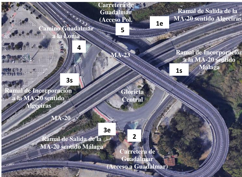
Ilustración 38. Accesos a Glorieta Central del Enlace (Pk. 3+000)
