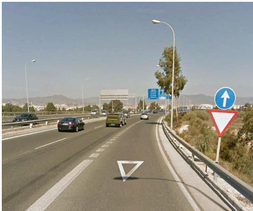
Ilustración 12. Carril de aceleración tipo paralelo para incorporación a la Autovía MA-20 sentido Málaga
