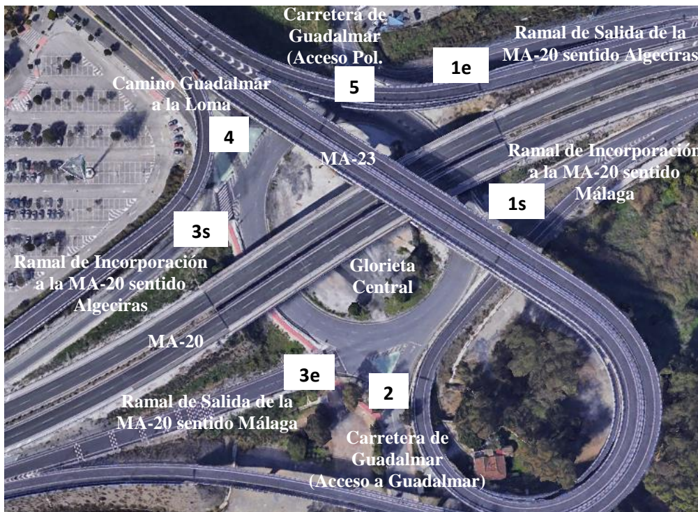
Ilustración 37. Accesos a Glorieta Central del Enlace (Pk. 3+000)
