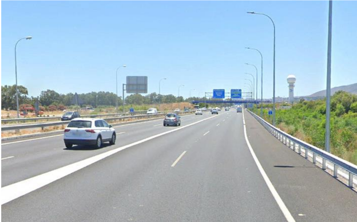
Ilustración 9. Vial de trenzado con dos carriles de circulación para incorporación a la Autovía MA-20 sentido Algeciras
