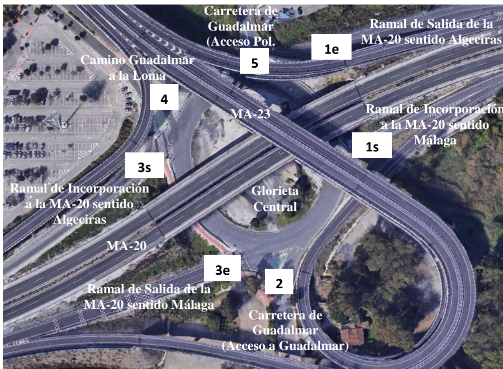
Ilustración 35. Accesos a Glorieta Central del Enlace (Pk. 3+000)
