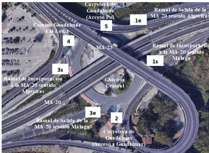
Ilustración 41. Accesos a Glorieta Central del Enlace (Pk. 3+000)
