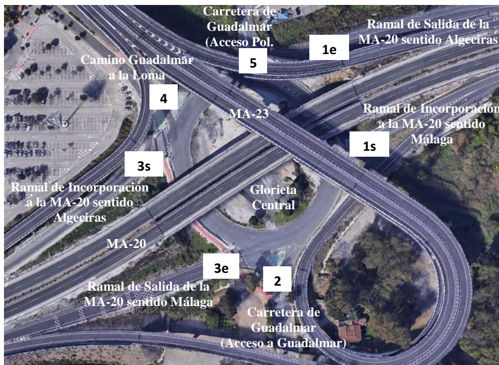
Ilustración 36. Accesos a Glorieta Central del Enlace (Pk. 3+000)
