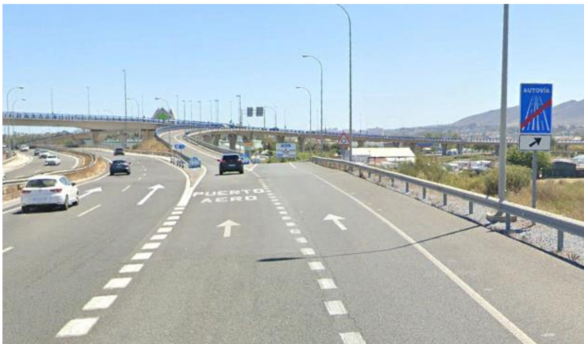
Ilustración 8. Desdoble del ramal hacia la Autovía MA-23 y hacia la glorieta central del Enlace 3
