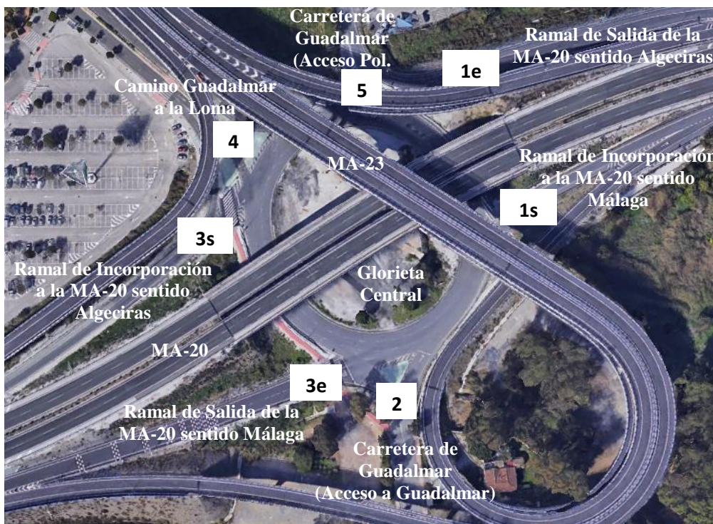
Ilustración 39. Accesos a Glorieta Central del Enlace (Pk. 3+000)
