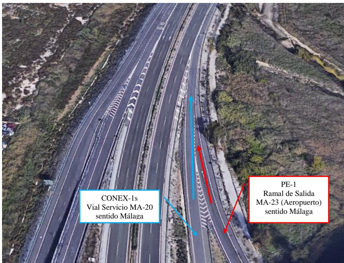
Ilustración 44. Foto Aérea del acceso del ramal de la MA-23 al vial de servicio de la MA-20 sentido Málaga
