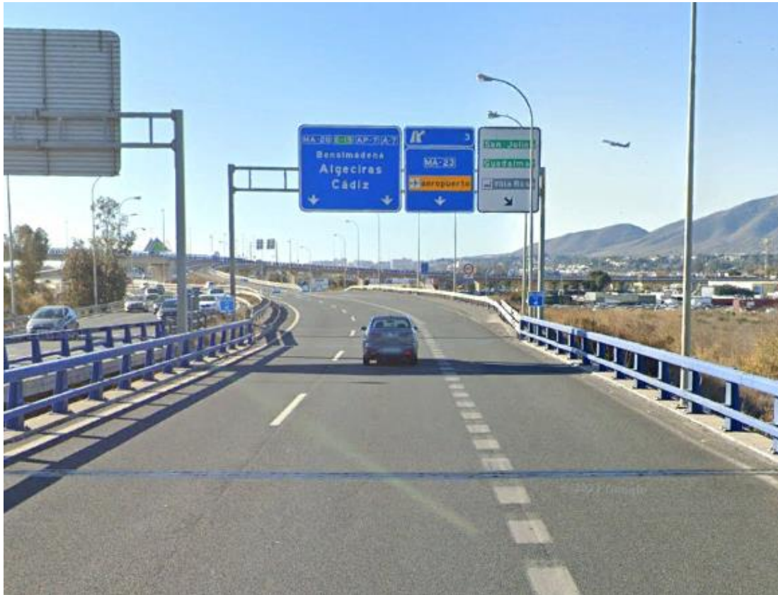
Ilustración 7. Ramal directo de salida 3 de la MA-20 sentido Algeciras.
