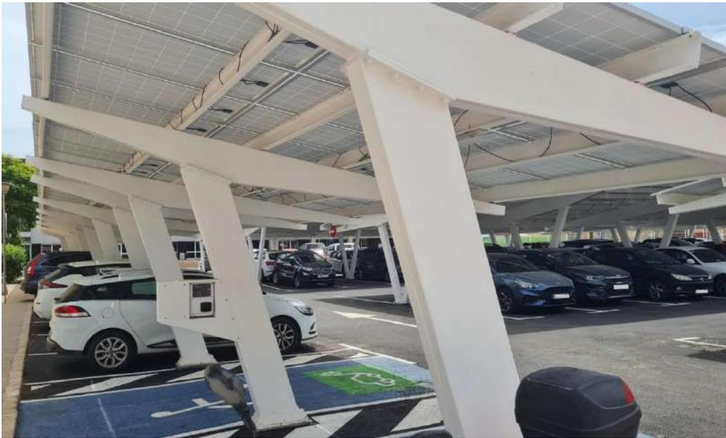
Ilustración 27. Ejemplo de marquesinas fotovoltaicas y punto de recarga.
