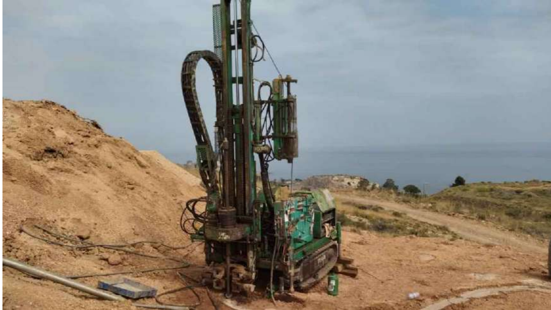
Realización de Sondeo 11.
