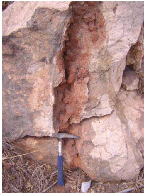
Fotografía Nº 31.- Fisura abierta y con paredes tapizadas de carbonatos.
