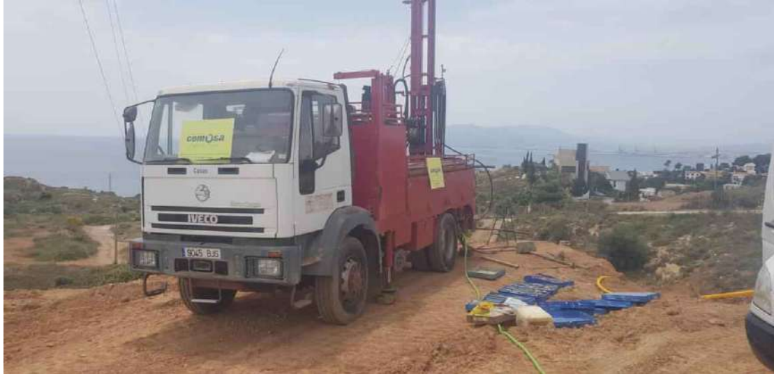
Realización de Sondeo 9.
