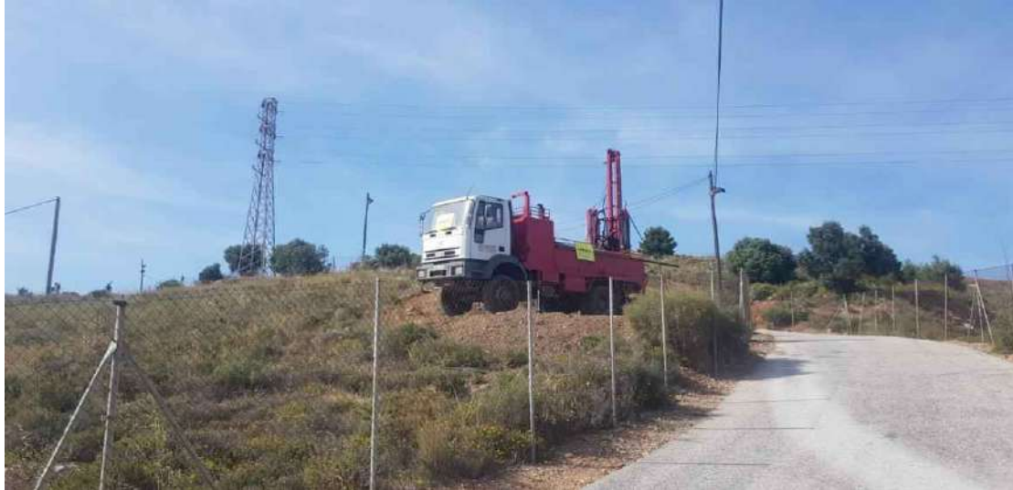
Realización de Sondeo 17.
