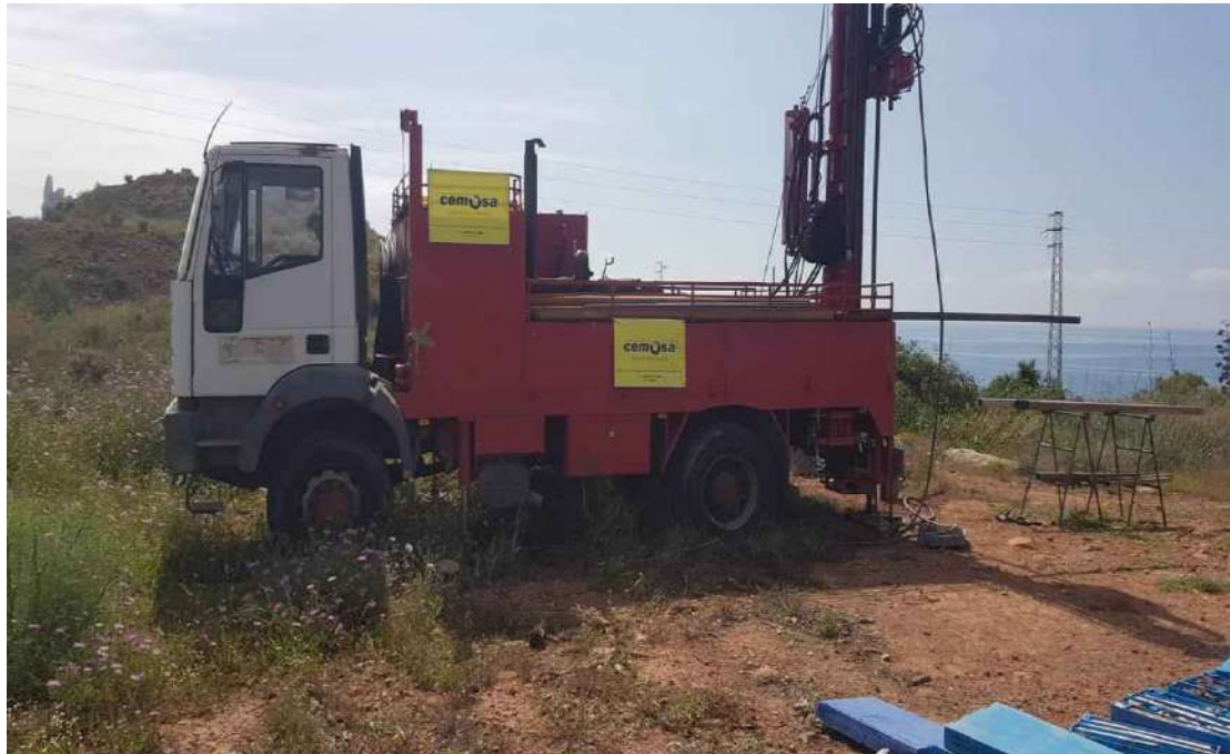
Realización del sondeo 1.
