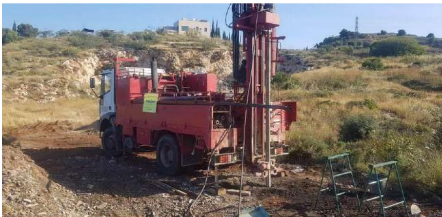
Fotografía Nº 21.- Emplazamiento del sondeo a rotación S-21.
