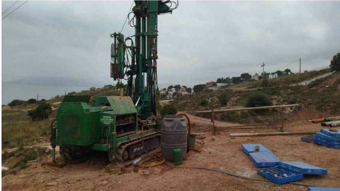
Realización de Sondeo 12.
