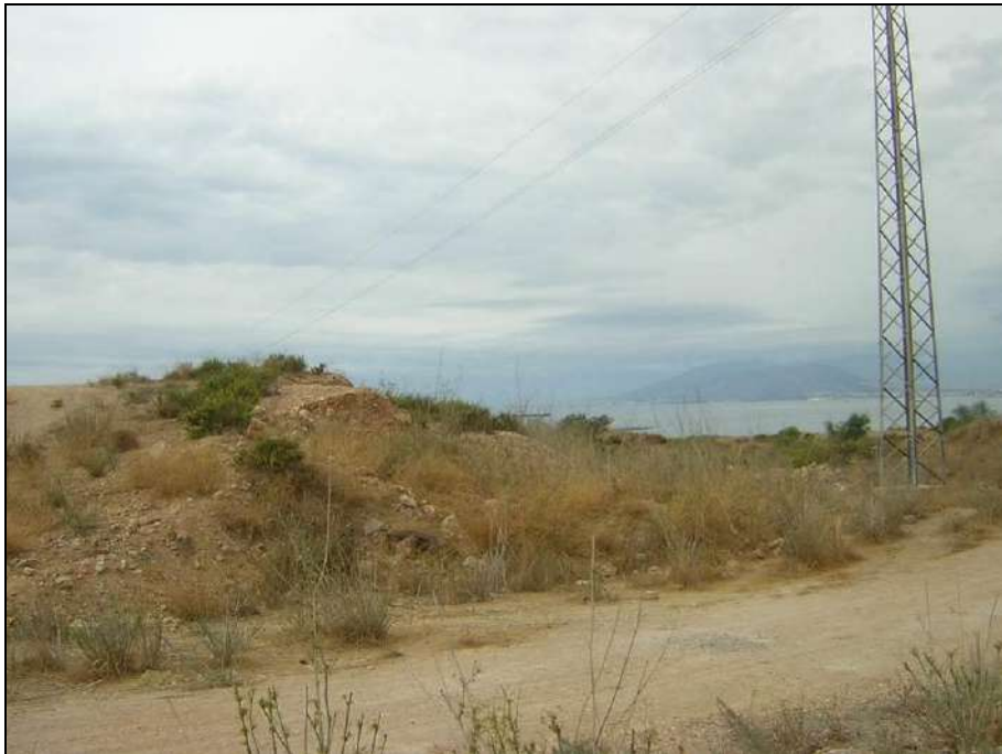
Fotografía Nº 37.- Variabilidad del espesor de los rellenos en "La Platera Oeste".. El poste del tendido eléctrico apoyaría sobre terreno natural.
