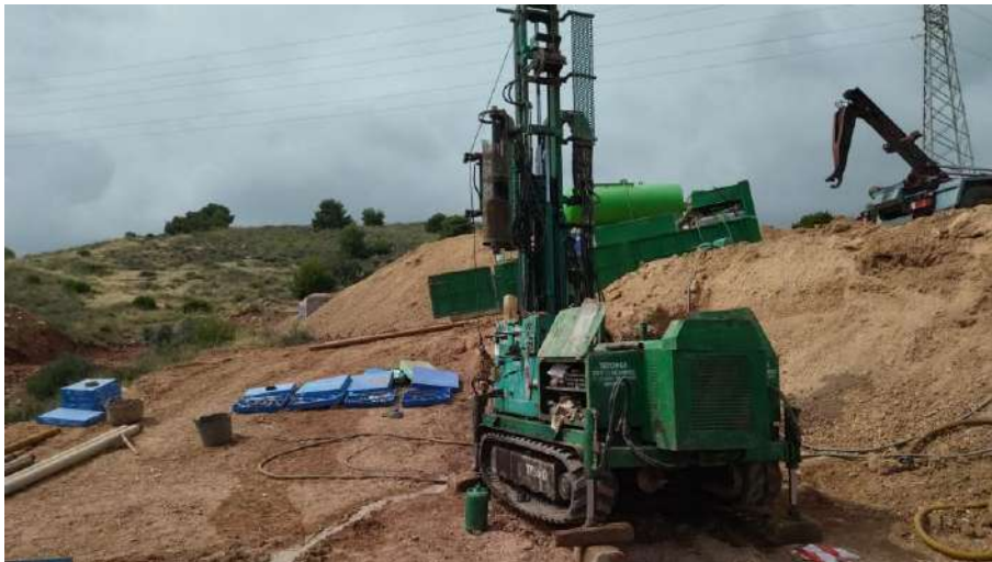
Fotografía Nº 11.- Emplazamiento del sondeo a rotación S-11.
