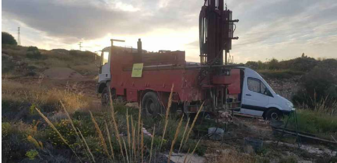
Realización de Sondeo 20.
