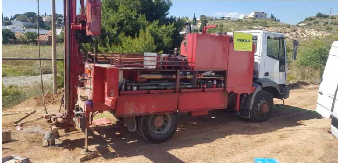
Realización del sondeo 2.
