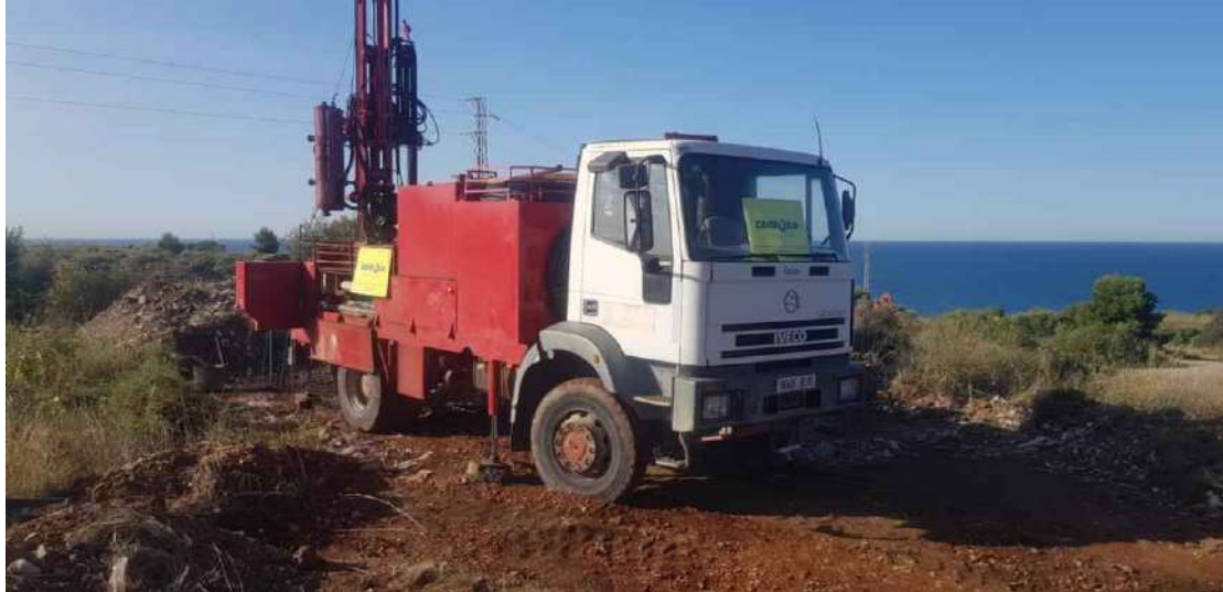
Realización de Sondeo 21.
