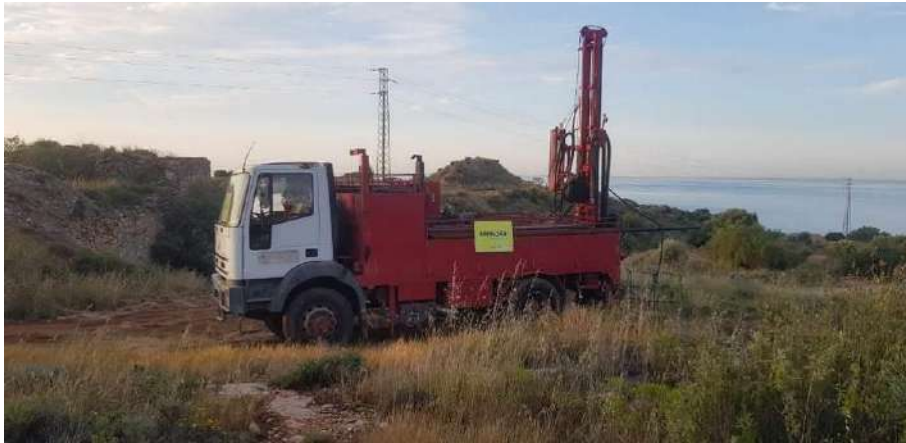
Fotografía Nº 20.- Emplazamiento del sondeo a rotación S-20.
