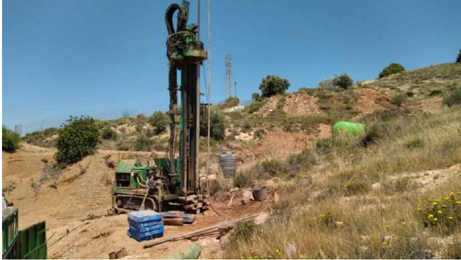
Fotografía Nº 13.- Emplazamiento del sondeo a rotación S-13.
