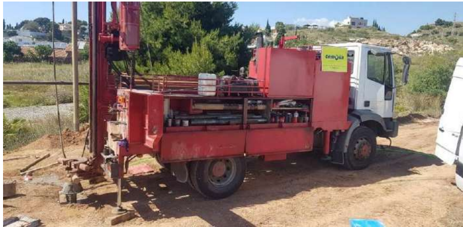
Fotografía N° 2.- Emplazamiento del sondeo a rotación S-02.
