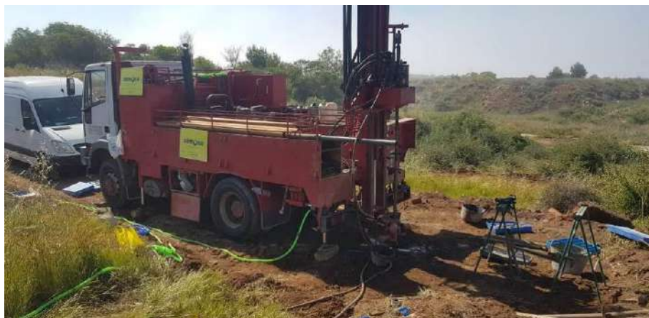
Fotografía N° 6.- Emplazamiento del sondeo a rotación S-06.
