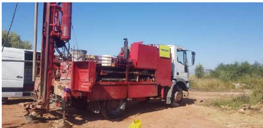
Fotografía N° 3.- Emplazamiento del sondeo a rotación S-03.
