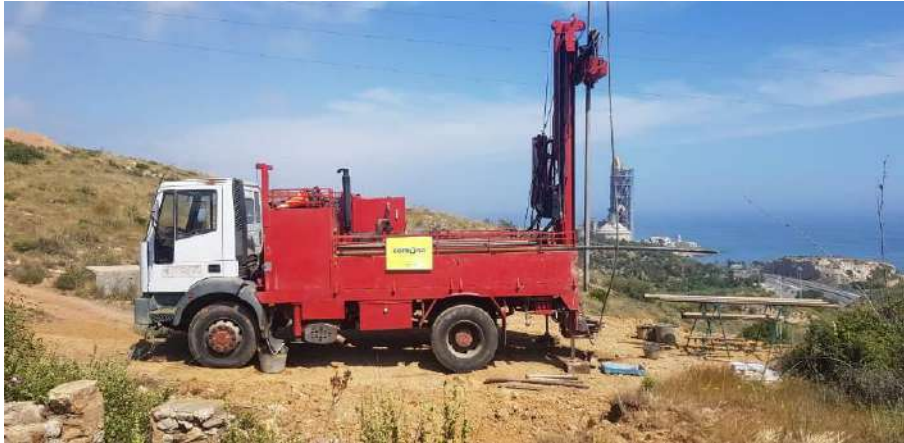
Fotografía N° 16.- Emplazamiento del sondeo a rotación S-16.
