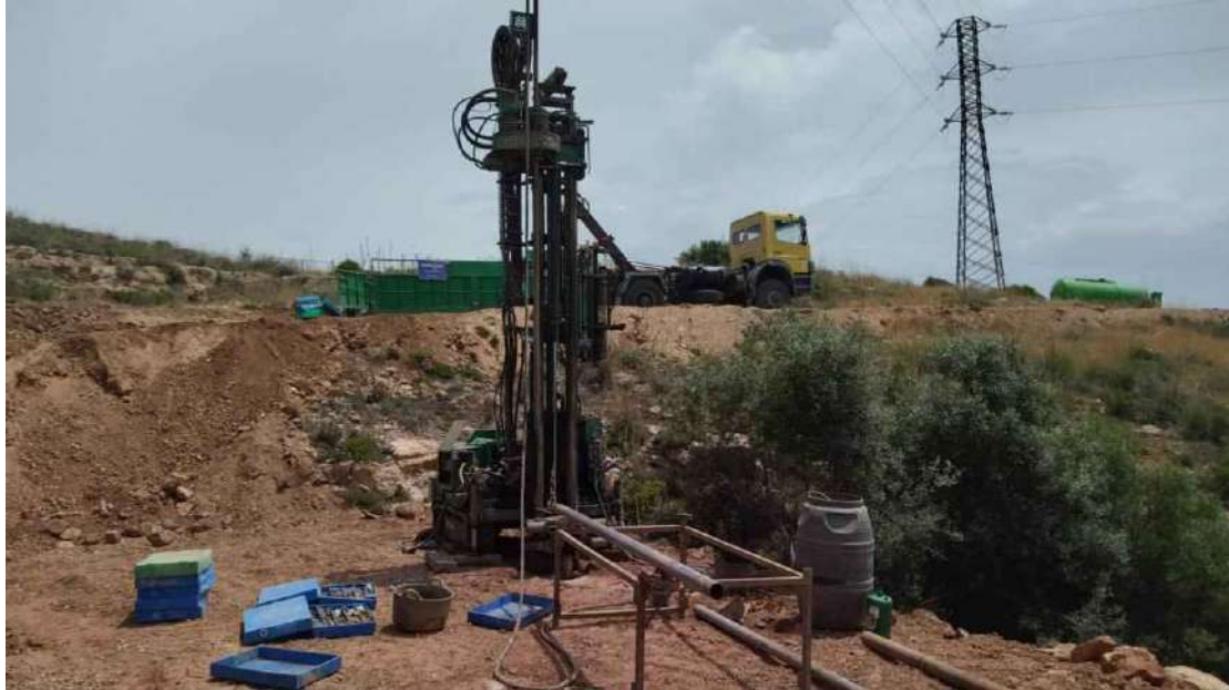
Realización de Sondeo 18.
