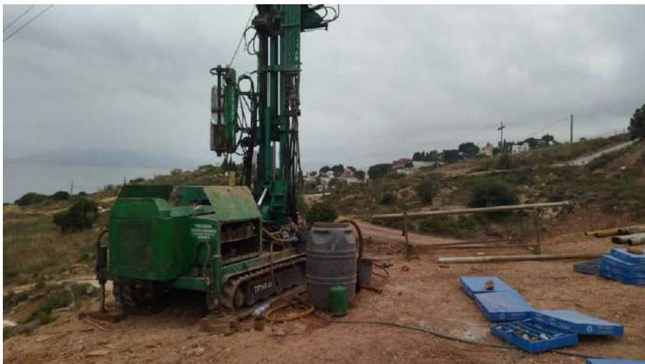
Fotografía Nº 12.- Emplazamiento del sondeo a rotación S-12.
