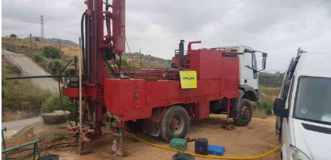
Realización de Sondeo 25.
