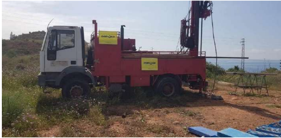
Fotografía N° 1.- Emplazamiento del sondeo a rotación S-01.
