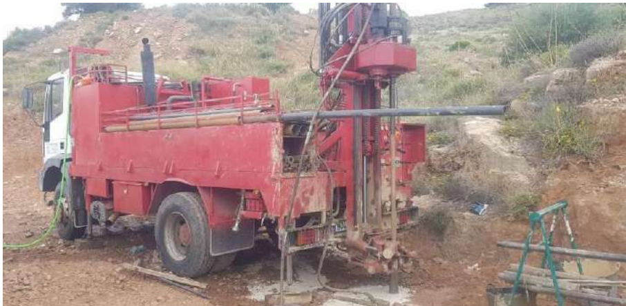
Fotografía Nº 8.- Emplazamiento del sondeo a rotación S-08.
