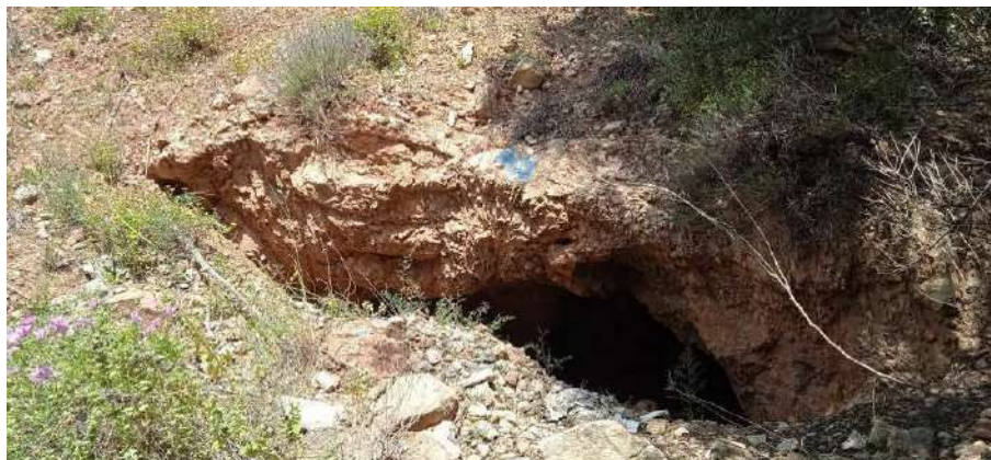
Figura Nº 116.- Panorámica de entrada a la galería.
