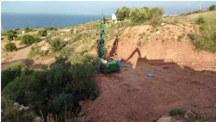
Fotografía Nº 23.- Emplazamiento del sondeo a rotación S-23.
