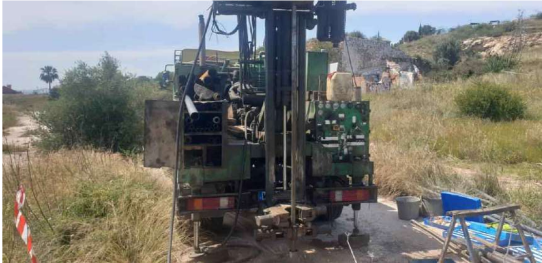
Realización de Sondeo 4.
