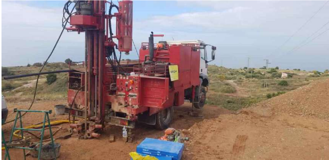
Realización de Sondeo 10.
