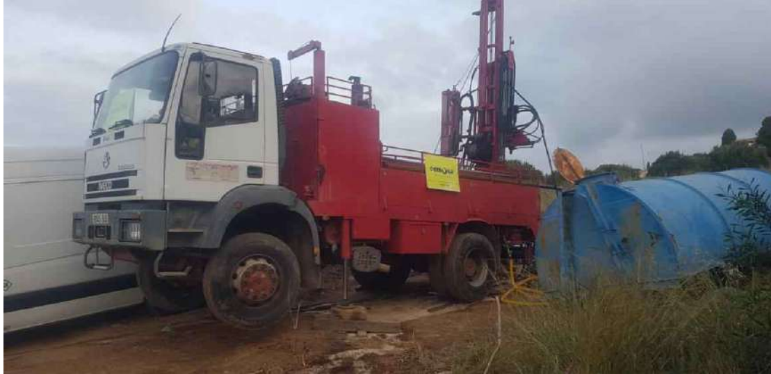
Realización de Sondeo 22.
