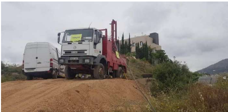
Fotografía Nº 24.- Emplazamiento del sondeo a rotación S-25.
