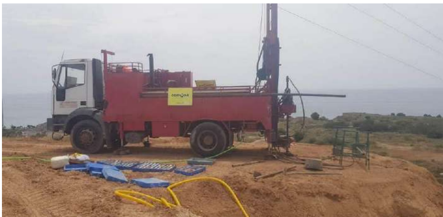
Fotografía Nº 9.- Emplazamiento del sondeo a rotación S-09.
