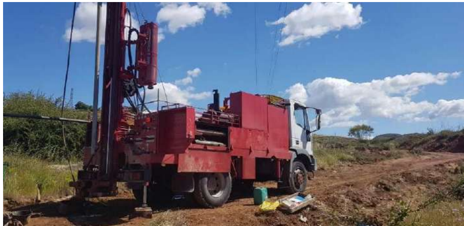
Fotografía N° 5.- Emplazamiento del sondeo a rotación S-05.
