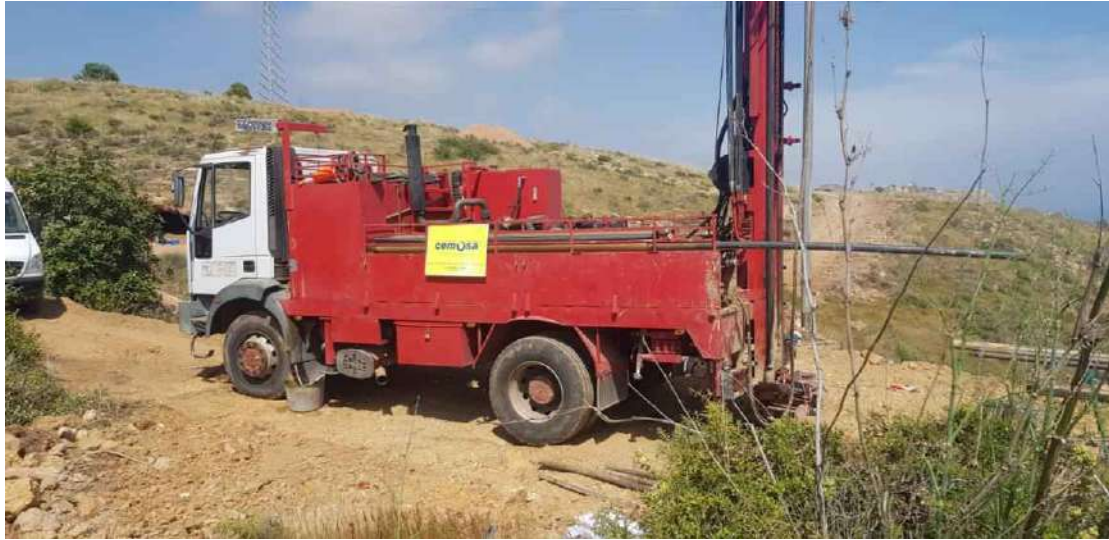
Realización de Sondeo 16.
