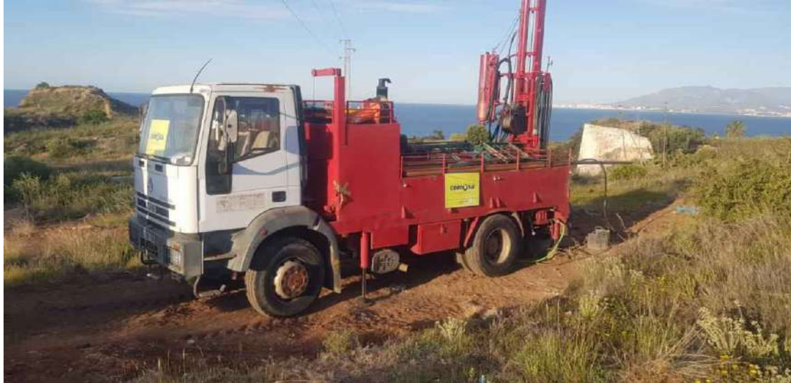
Realización de Sondeo 7.
