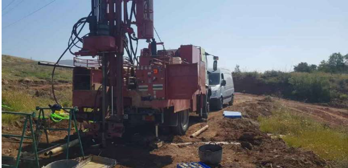
Realización de Sondeo 6.
