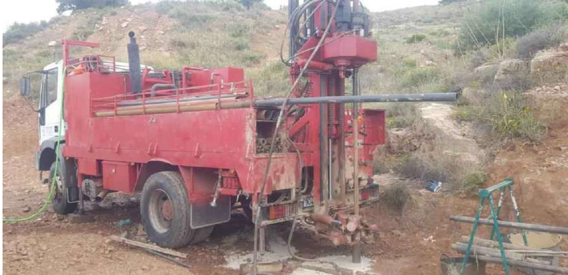
Realización de Sondeo 8.
