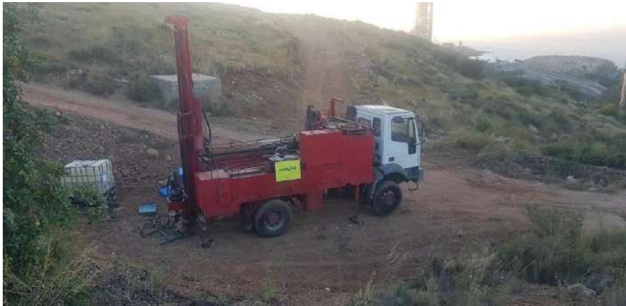
Fotografía Nº 14.- Emplazamiento del sondeo a rotación S-14.
