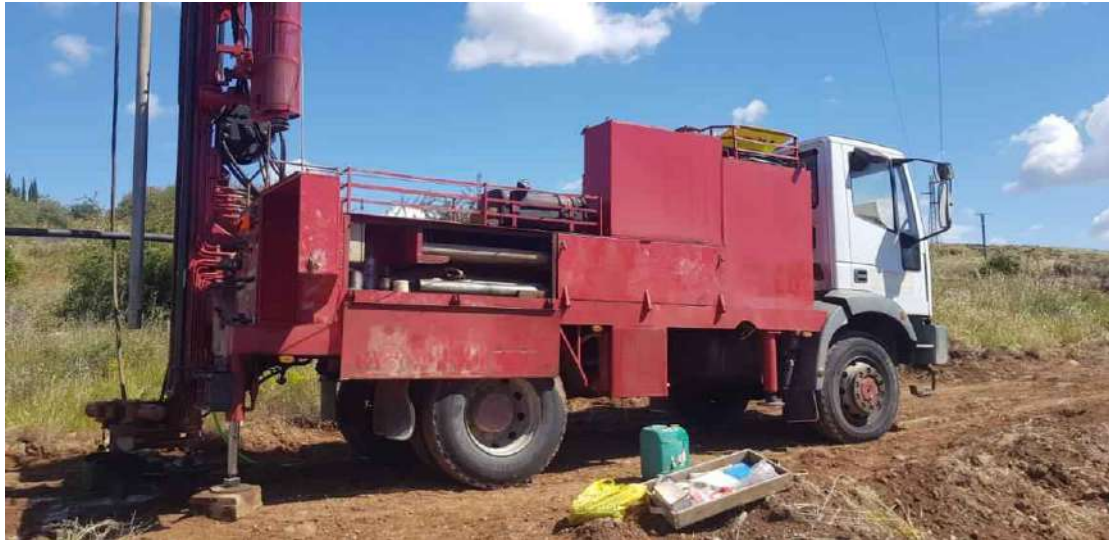
Realización de Sondeo 5.
