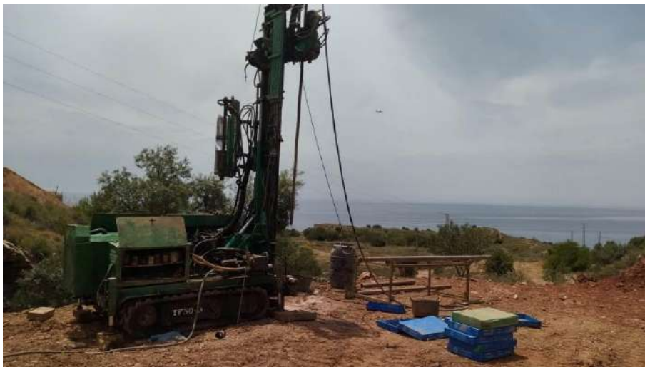
Fotografía N° 18.- Emplazamiento del sondeo a rotación S-18.
