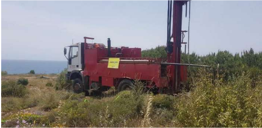
Fotografía Nº 19.- Emplazamiento del sondeo a rotación S-19.
