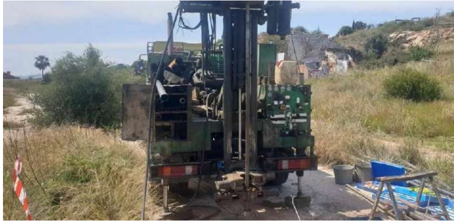
Fotografía N° 4.- Emplazamiento del sondeo a rotación S-04.
