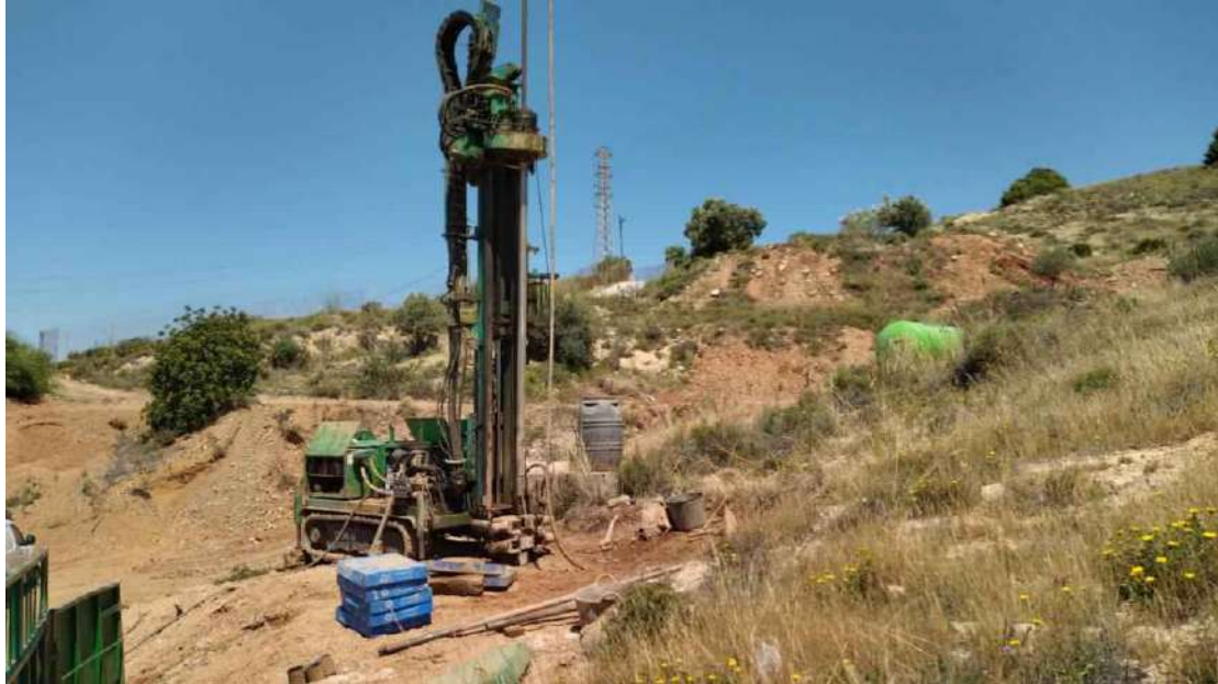
Realización de Sondeo 13.
