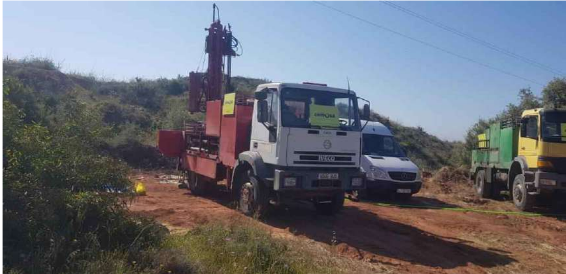
Realización de Sondeo 3.
