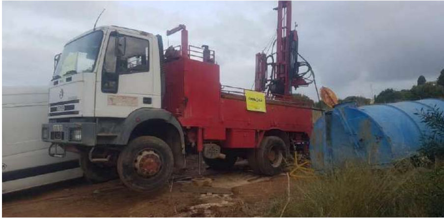
Fotografía Nº 22.- Emplazamiento del sondeo a rotación S-22.
