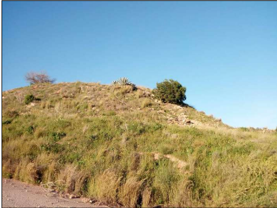
Fotografía Nº 40.- Taludes artificiales de los depósitos de rellenos de escombros a lo largo de la "La Platera Este".
