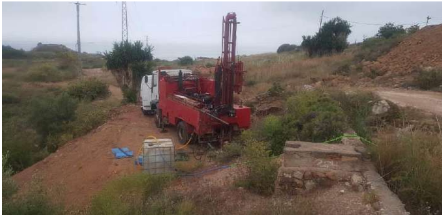
Fotografía Nº 15.- Emplazamiento del sondeo a rotación S-15.
