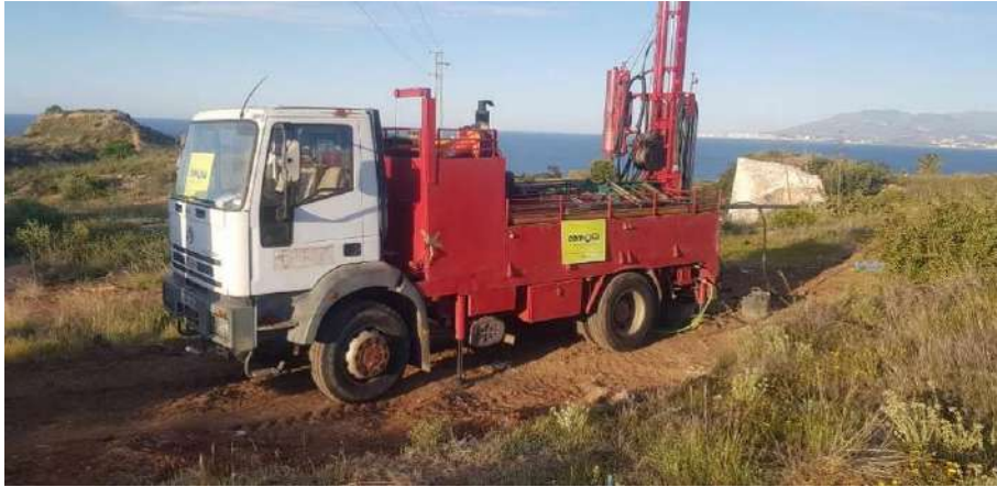
Fotografía Nº 7.- Emplazamiento del sondeo a rotación S-07.
