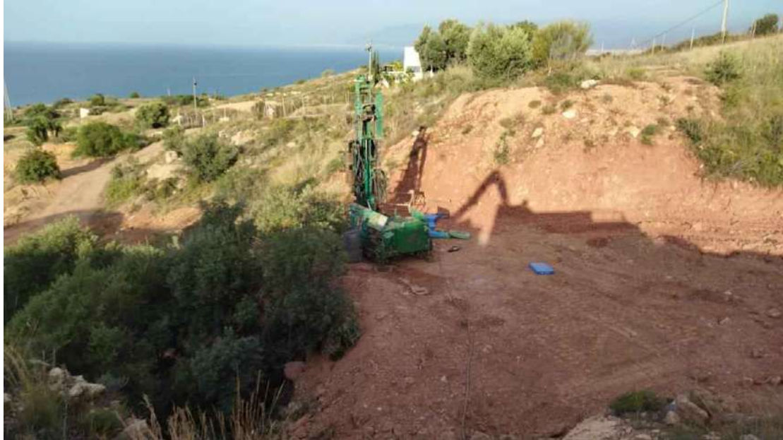
Realización de Sondeo 23.
