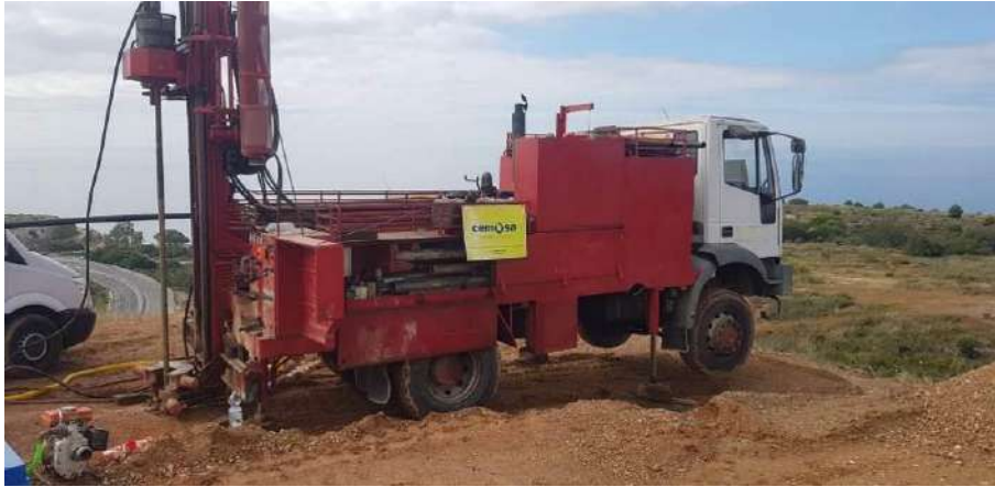
Fotografía Nº 10.- Emplazamiento del sondeo a rotación S-10.
