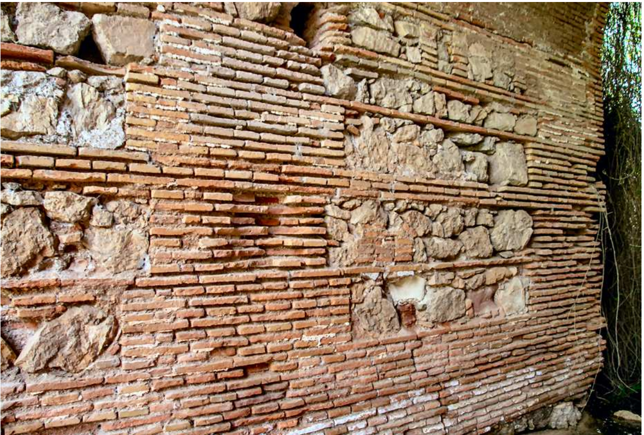
DETALLE DE LA FÁBRICA INTERIOR
