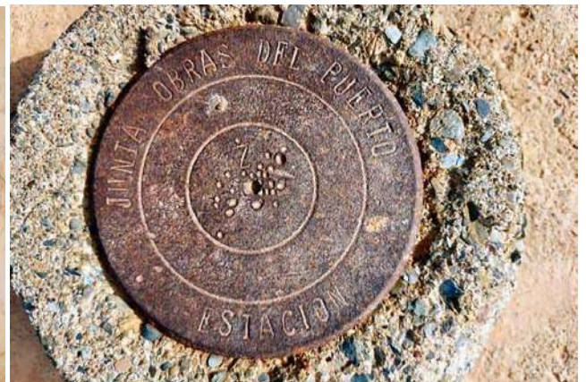
PUNTO TOPOGRÁFICO DE LA JUNTA DEL PUERTO
