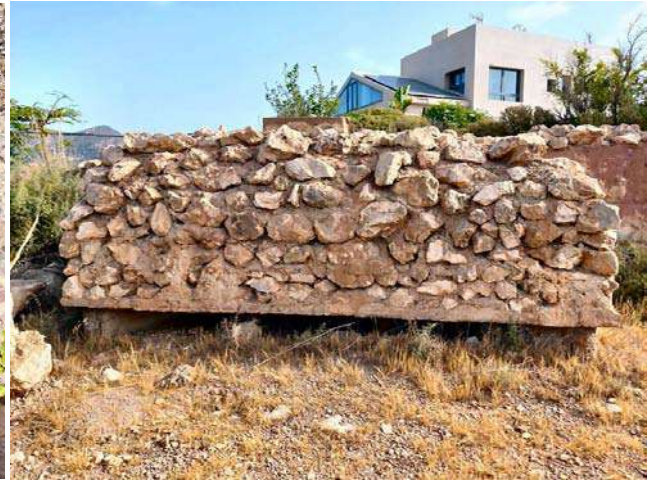
EXTERIOR DEL FRENTE SUR
