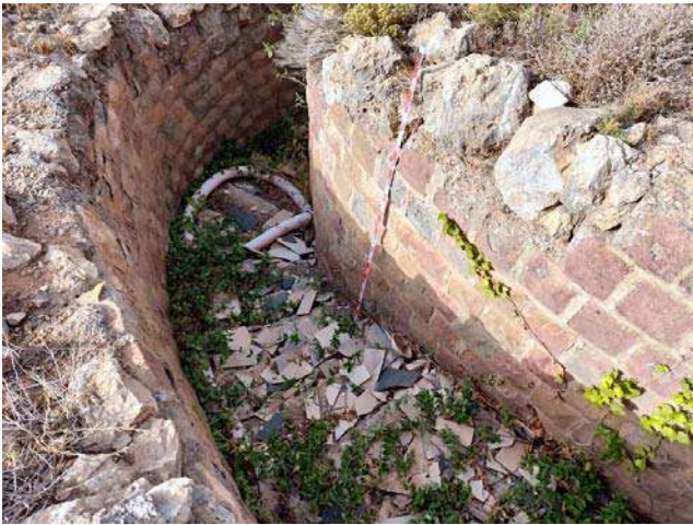
ESCALERA DE ACCESO
