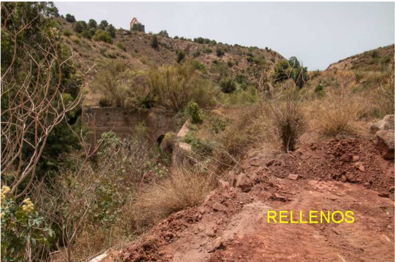
VISTA DESDE EL NOROESTE DE LOS RELLENOS SOBRE EL PUENTE (5-7-2022)
