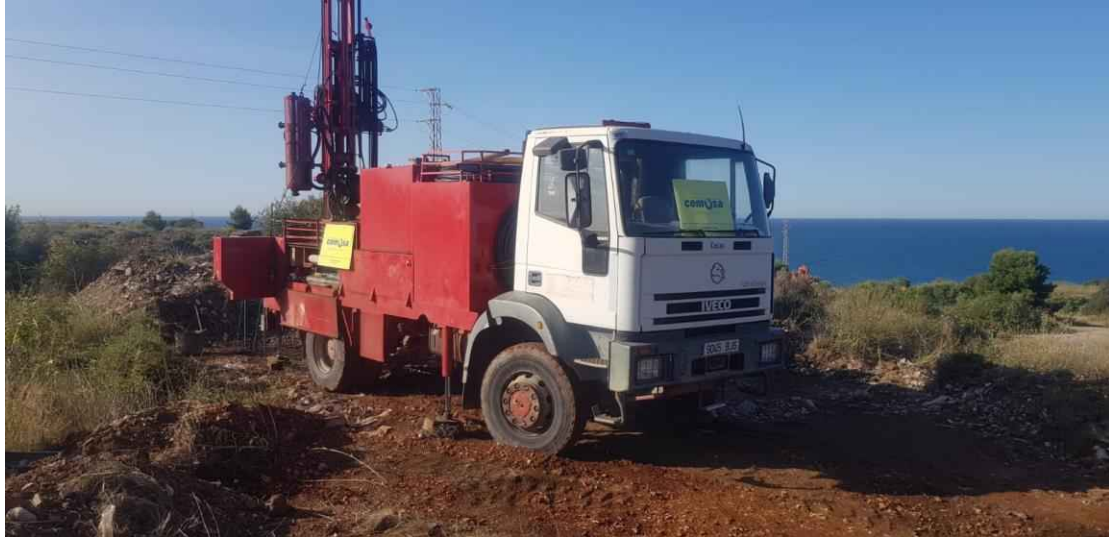
Realización de Sondeo 21.
