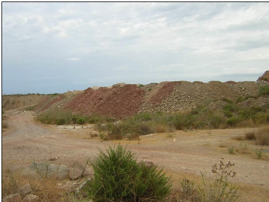
Fotografía Nº 35.- Rellenos recientes a lo largo de la "La Platera Oeste".
