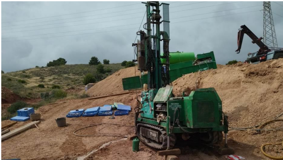
Fotografía Nº 11.- Emplazamiento del sondeo a rotación S-11.
