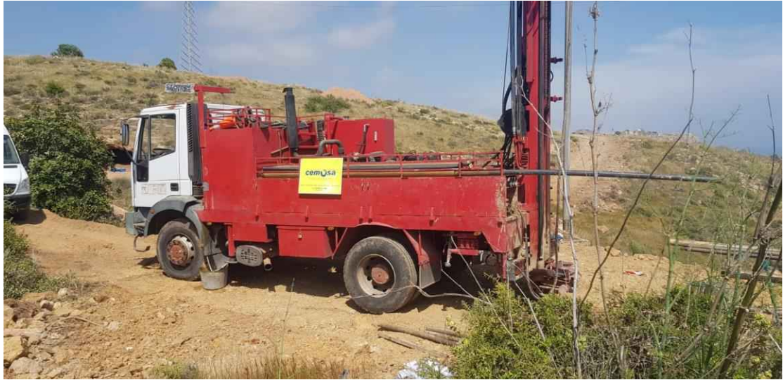
Realización de Sondeo 16.
