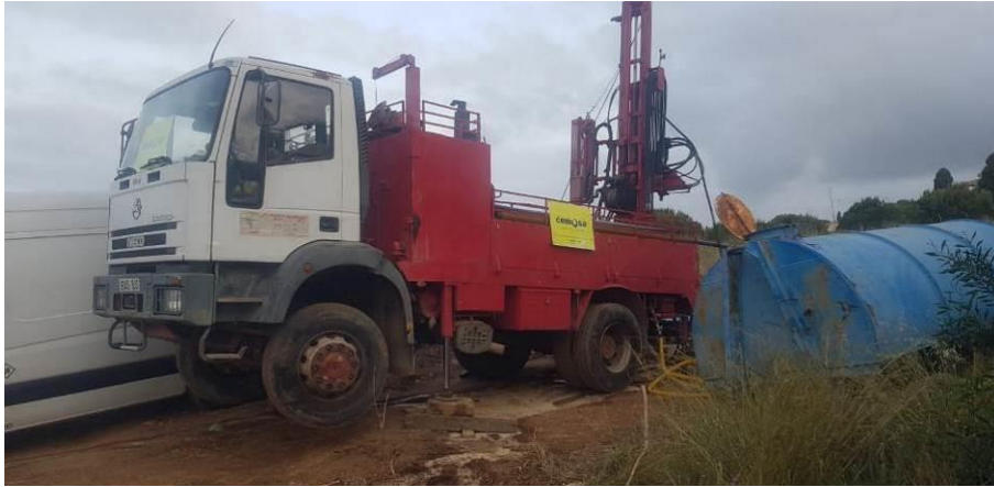
Fotografía Nº 22.- Emplazamiento del sondeo a rotación S-22.
