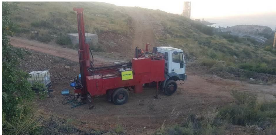
Fotografía Nº 14.- Emplazamiento del sondeo a rotación S-14.
