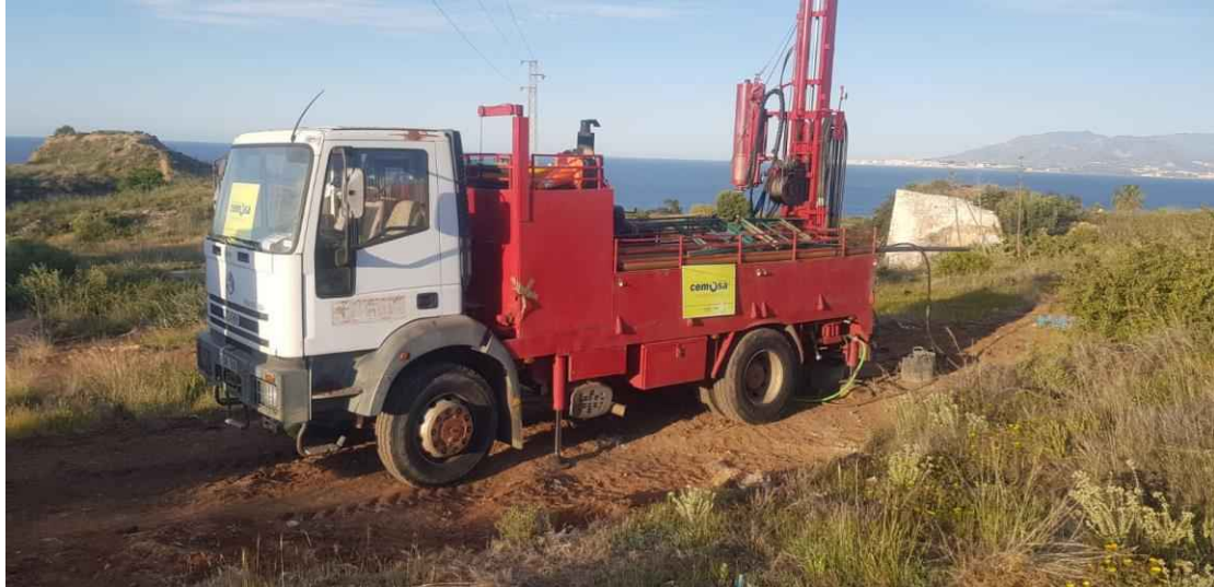
Realización de Sondeo 7.
