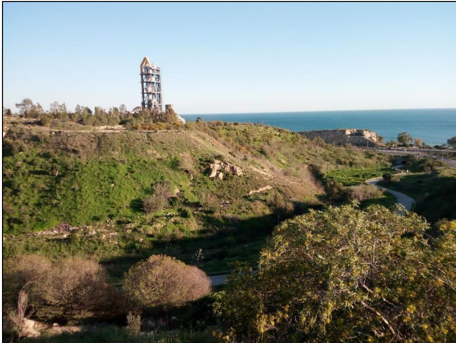
Fotografía Nº 41.- Taludes artificiales de los depósitos de rellenos de escombros tapando frentes de canteras a lo largo de la "La Platera Este".
