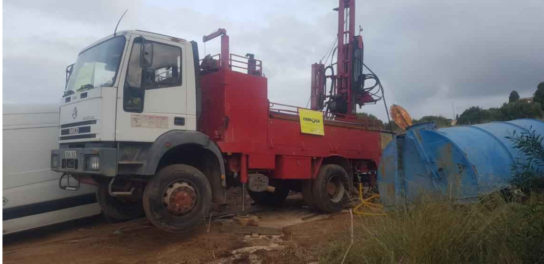
Realización de Sondeo 22.
