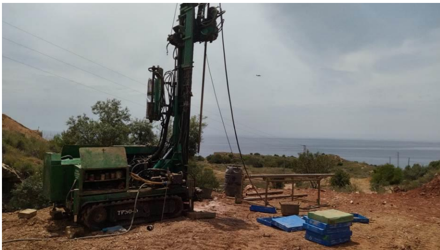
Fotografía Nº 18.- Emplazamiento del sondeo a rotación S-18.
