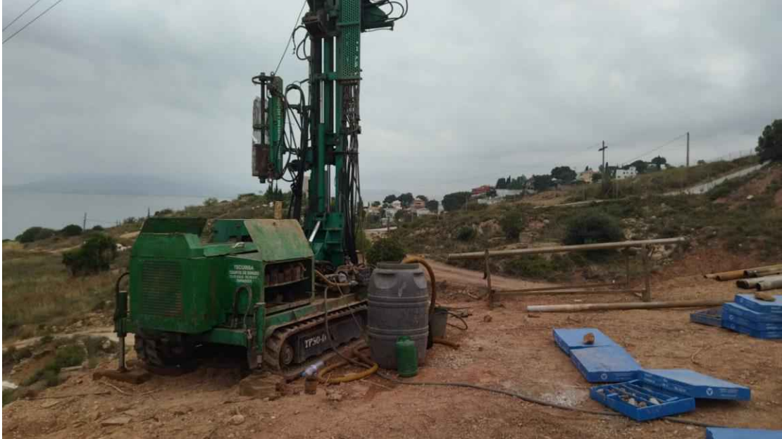
Realización de Sondeo 12.
