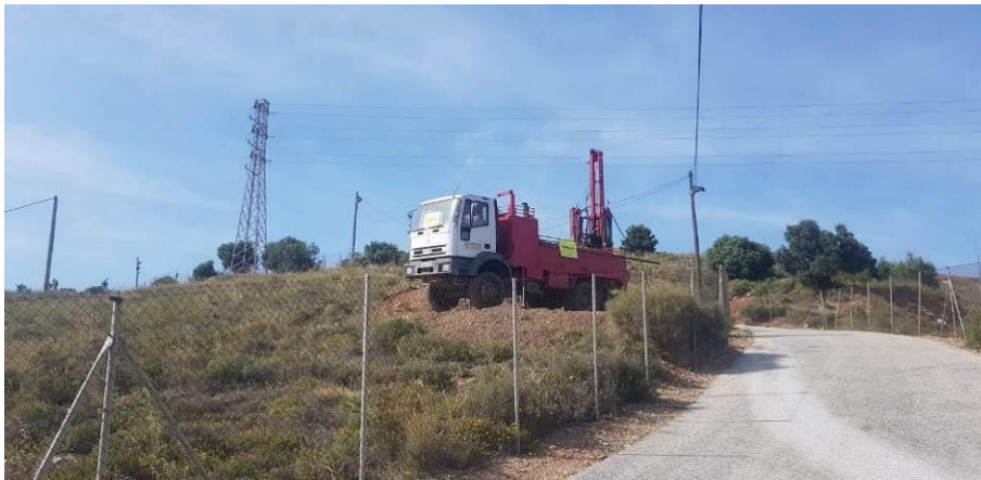
Fotografía Nº 17.- Emplazamiento del sondeo a rotación S-17.
