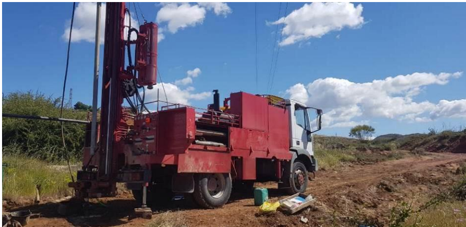
Fotografía N° 5.- Emplazamiento del sondeo a rotación S-05.
