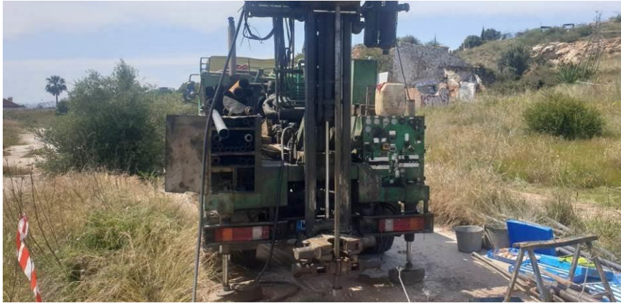
Fotografía N° 4.- Emplazamiento del sondeo a rotación S-04.
