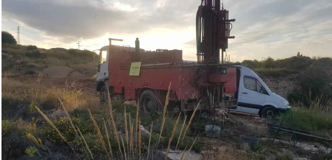
Realización de Sondeo 20.
