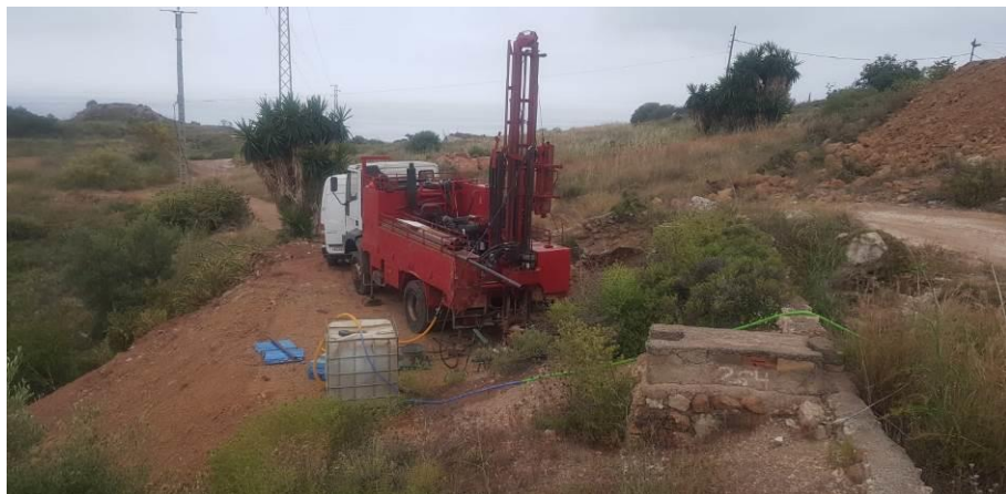
Fotografía Nº 15.- Emplazamiento del sondeo a rotación S-15.
