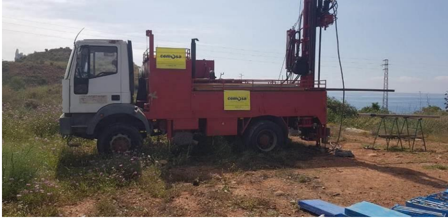
Fotografía N° 1.- Emplazamiento del sondeo a rotación S-01.
