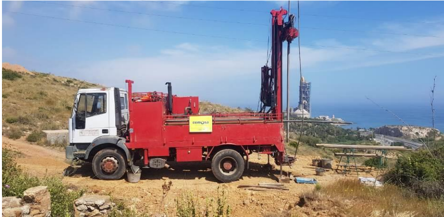
Fotografía Nº 16.- Emplazamiento del sondeo a rotación S-16.
