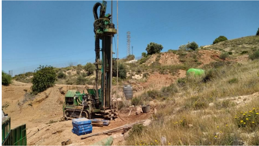
Fotografía Nº 13.- Emplazamiento del sondeo a rotación S-13.
