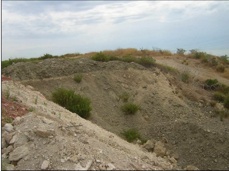
Fotografía Nº 36.- Aspecto de la heterogeneidad de los rellenos en "La Platera Oeste".. En primer término acero de obra.
