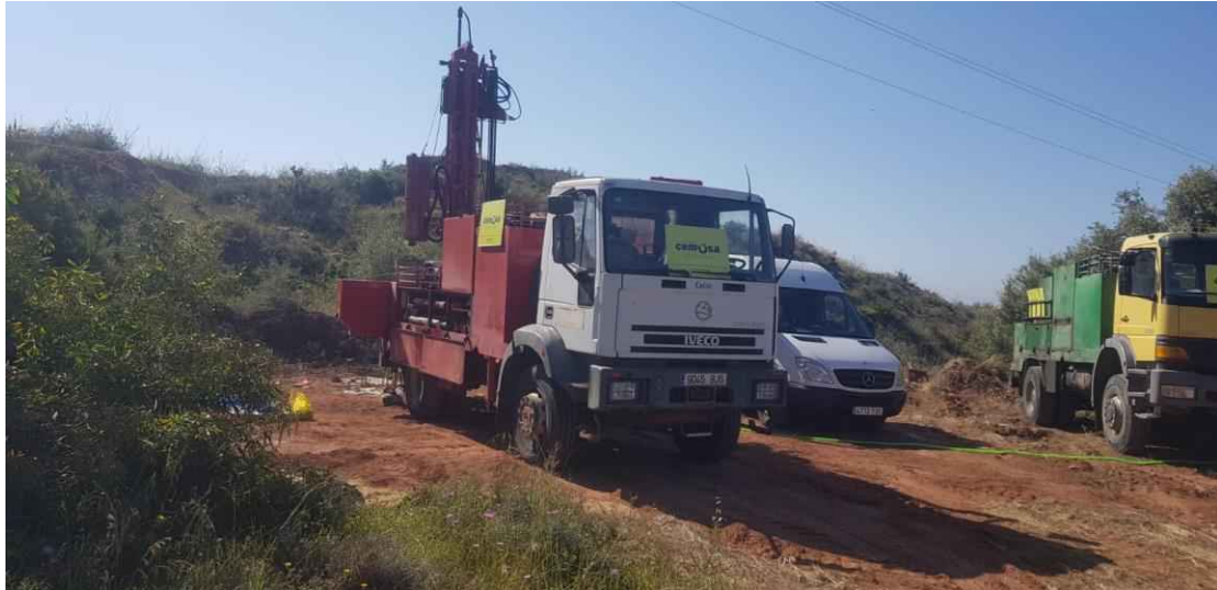
Realización de Sondeo 3.
