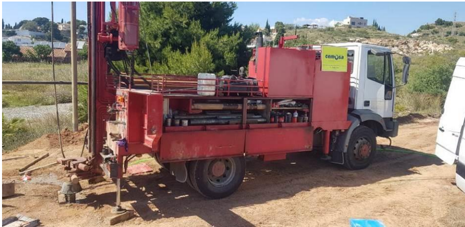
Fotografía N° 2.- Emplazamiento del sondeo a rotación S-02.
