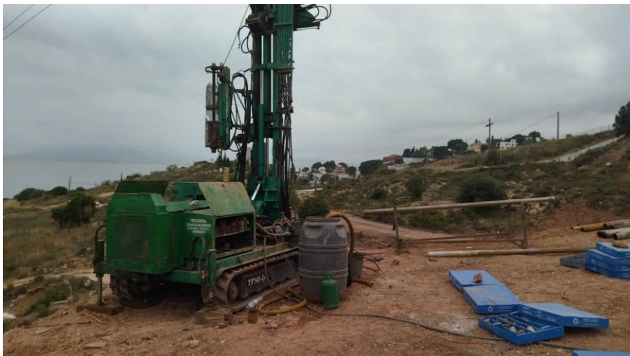
Fotografía Nº 12.- Emplazamiento del sondeo a rotación S-12.
