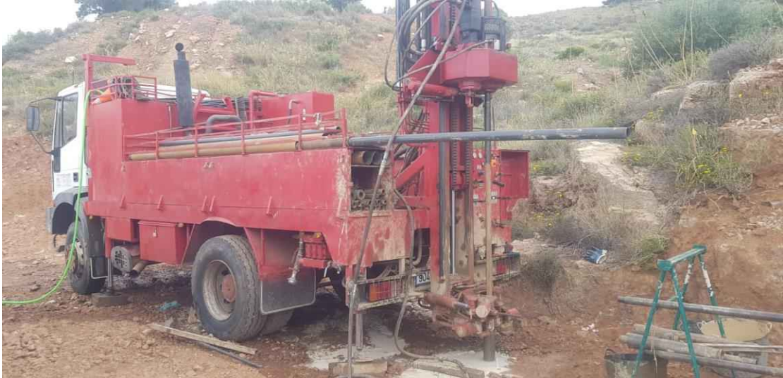
Realización de Sondeo 8.
