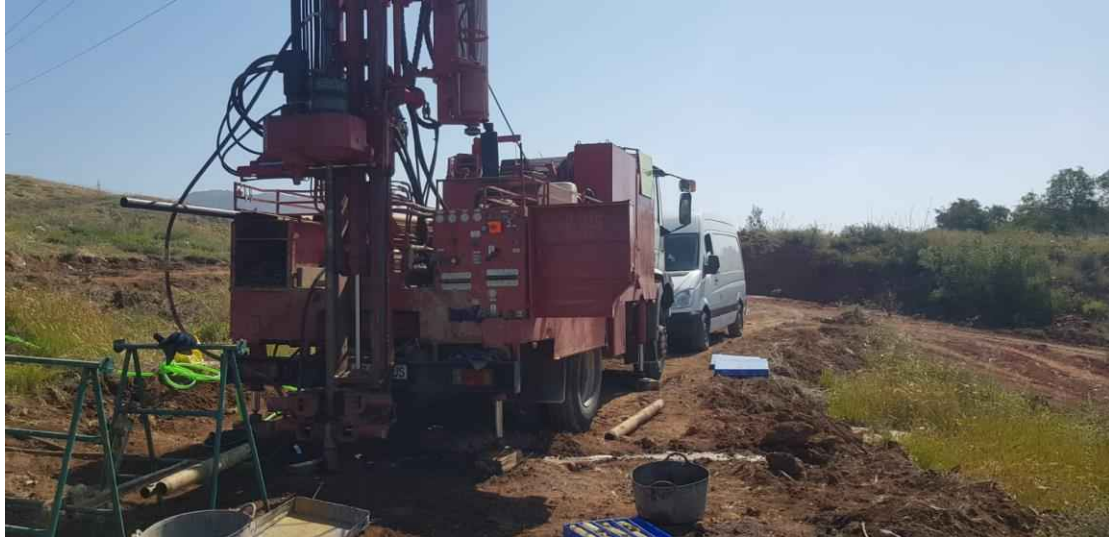
Realización de Sondeo 6.
