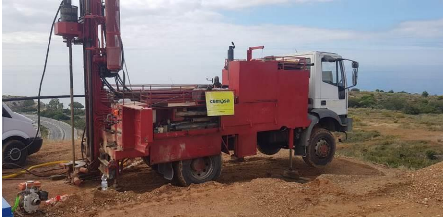
Fotografía Nº 10.- Emplazamiento del sondeo a rotación S-10.
