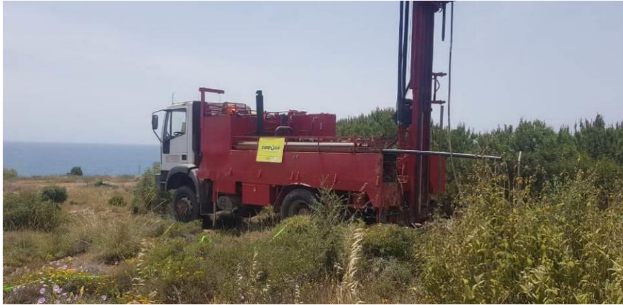
Fotografía Nº 19.- Emplazamiento del sondeo a rotación S-19.
