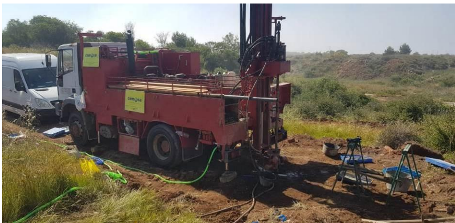
Fotografía N° 6.- Emplazamiento del sondeo a rotación S-06.
