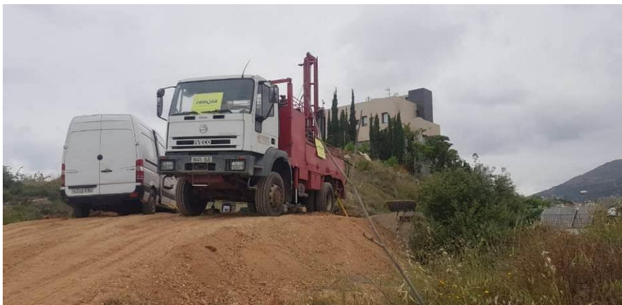
Fotografía Nº 24.- Emplazamiento del sondeo a rotación S-25.
