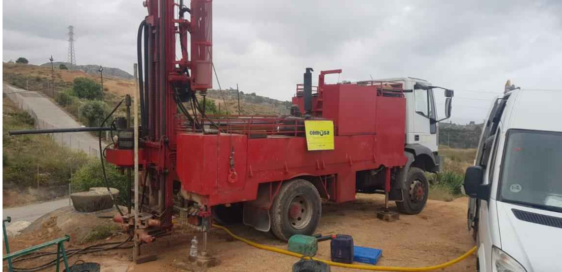
Realización de Sondeo 25.
