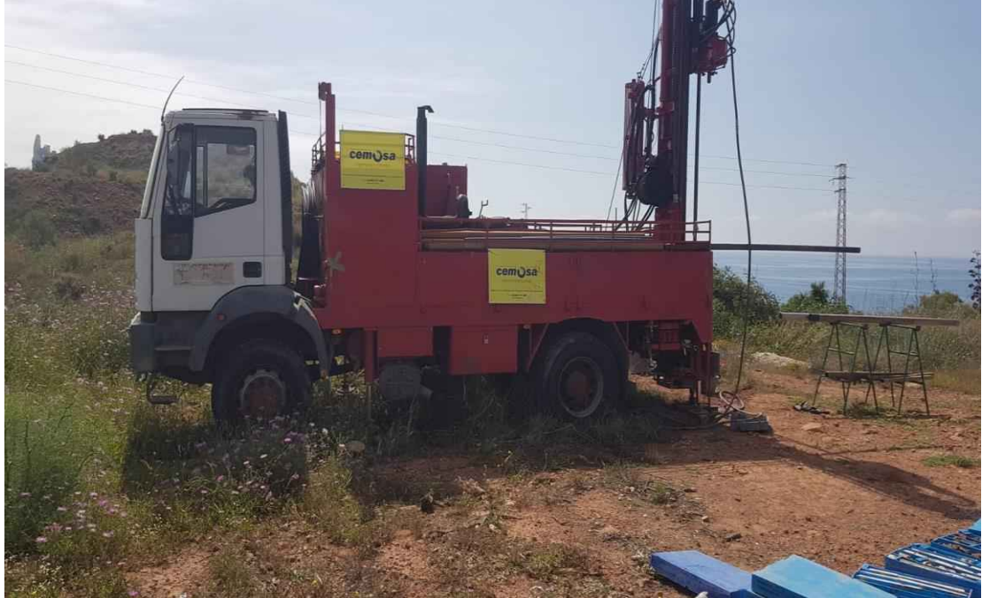
Realización del sondeo 1.
