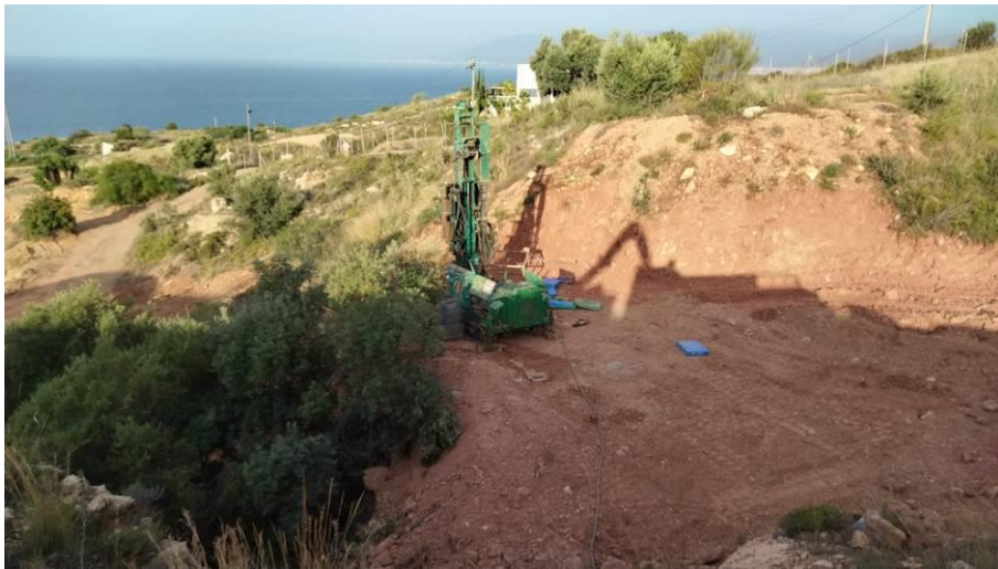
Fotografía Nº 23.- Emplazamiento del sondeo a rotación S-23.
