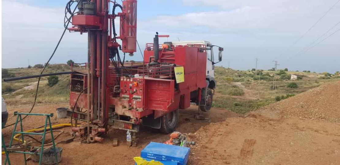
Realización de Sondeo 10.
