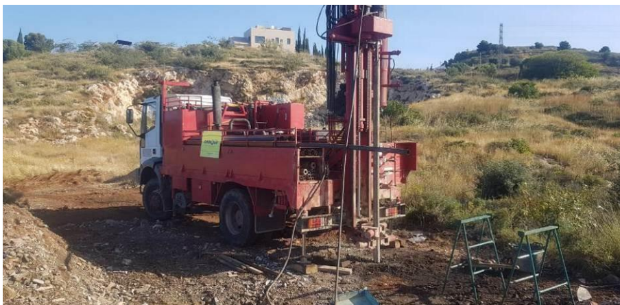
Fotografía Nº 21.- Emplazamiento del sondeo a rotación S-21.
