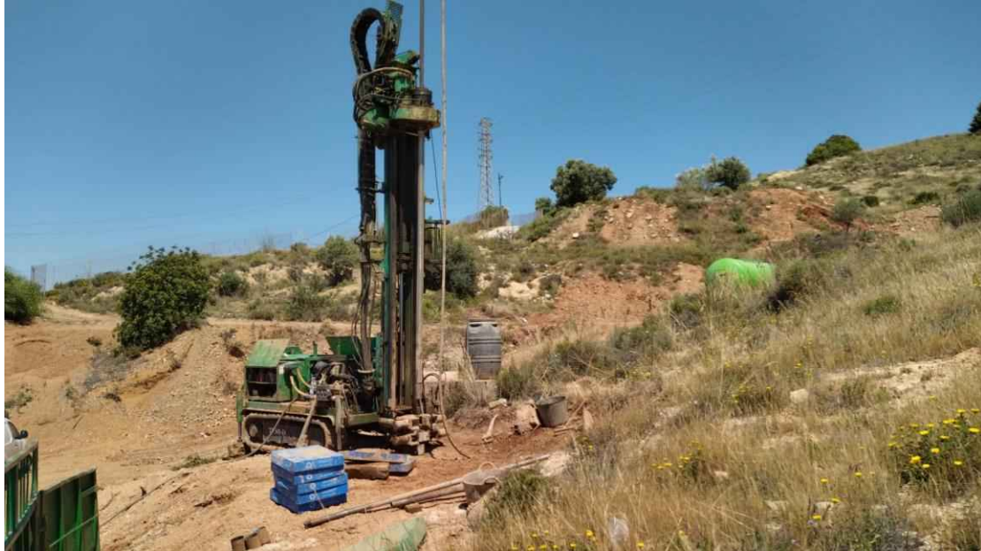
Realización de Sondeo 13.
