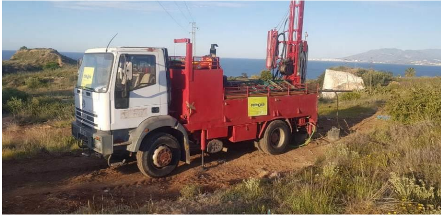
Fotografía N° 7.- Emplazamiento del sondeo a rotación S-07.
