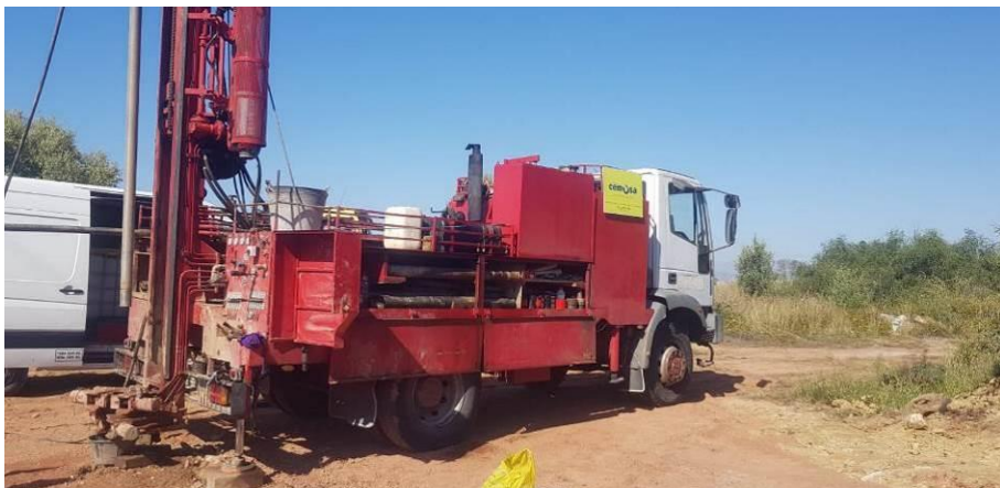
Fotografía N° 3.- Emplazamiento del sondeo a rotación S-03.
