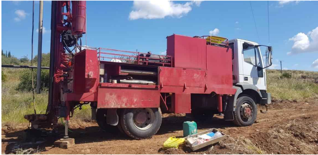
Realización de Sondeo 5.
