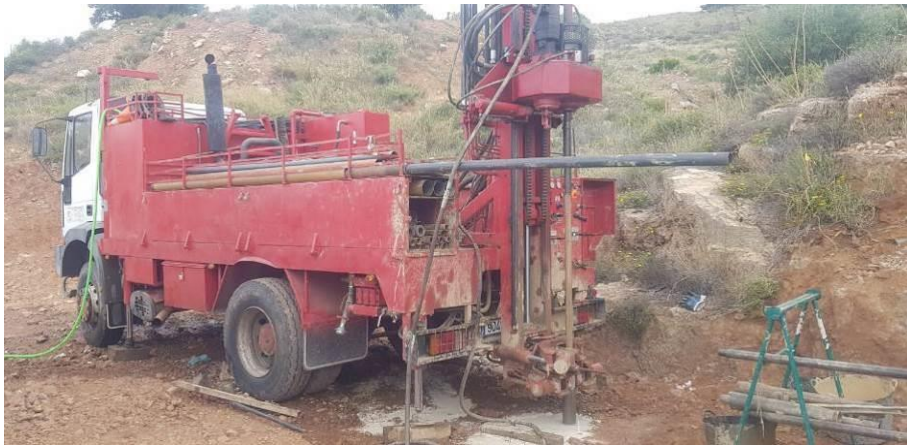
Fotografía N° 8.- Emplazamiento del sondeo a rotación S-08.
