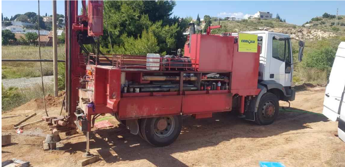
Realización del sondeo 2.
