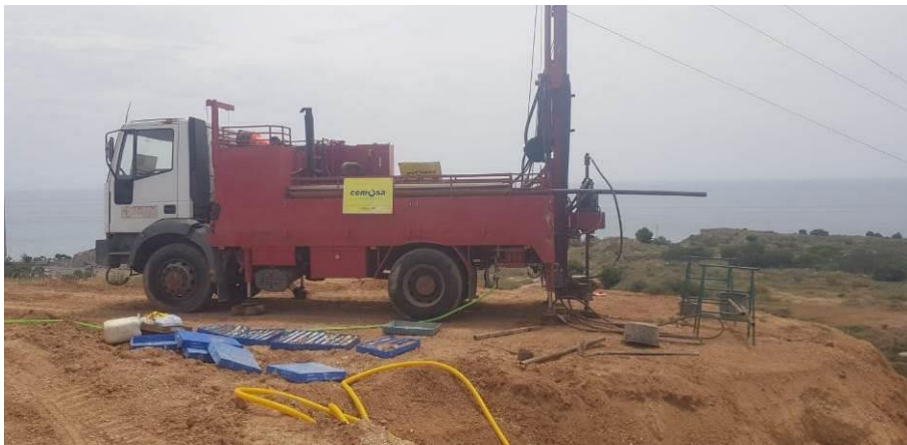
Fotografía N° 9.- Emplazamiento del sondeo a rotación S-09.
