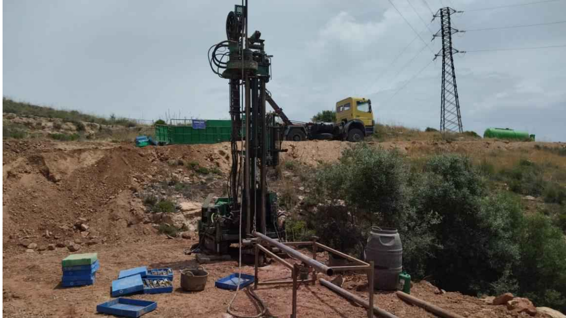
Realización de Sondeo 18.
