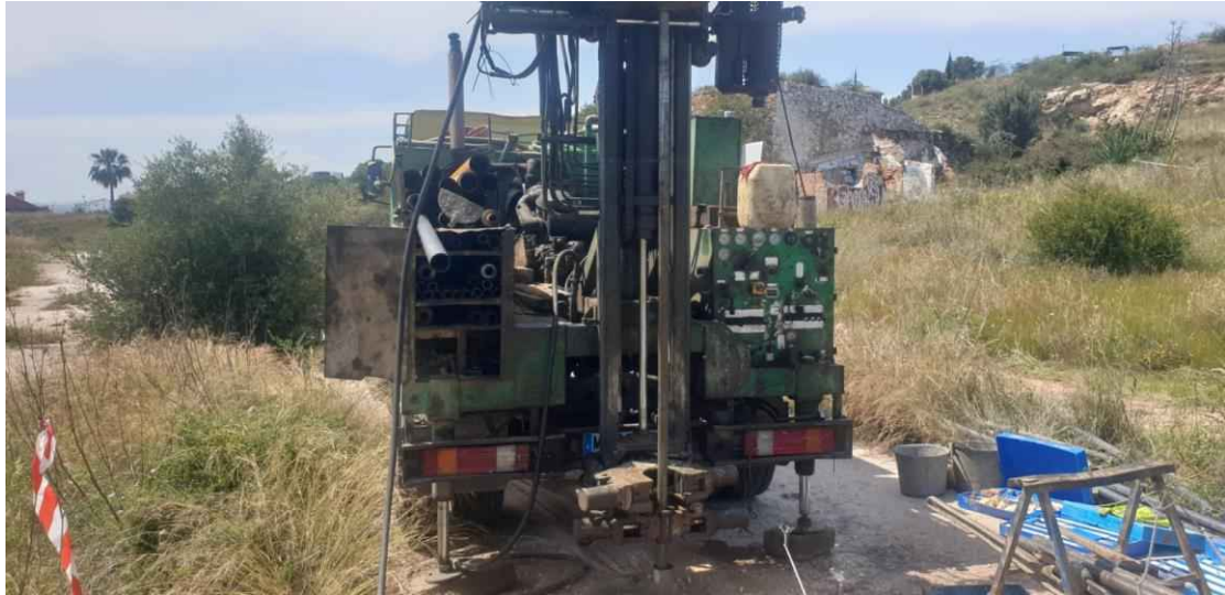
Realización de Sondeo 4.
