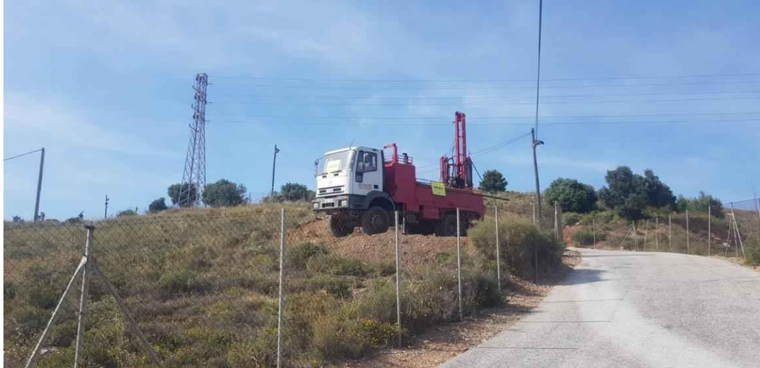
Realización de Sondeo 17.
