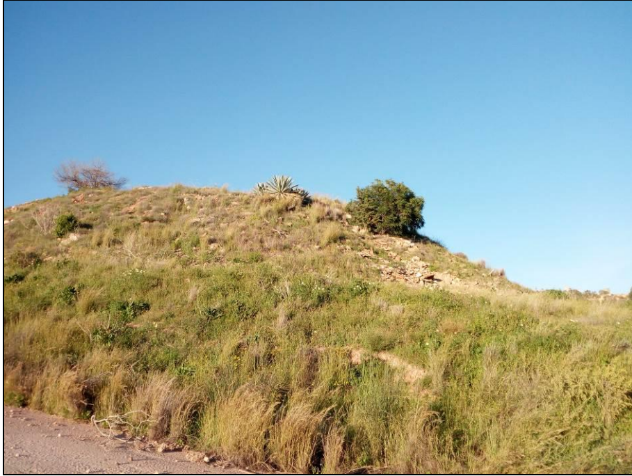
Fotografía Nº 40.- Taludes artificiales de los depósitos de rellenos de escombros a lo largo de la "La Platera Este".
