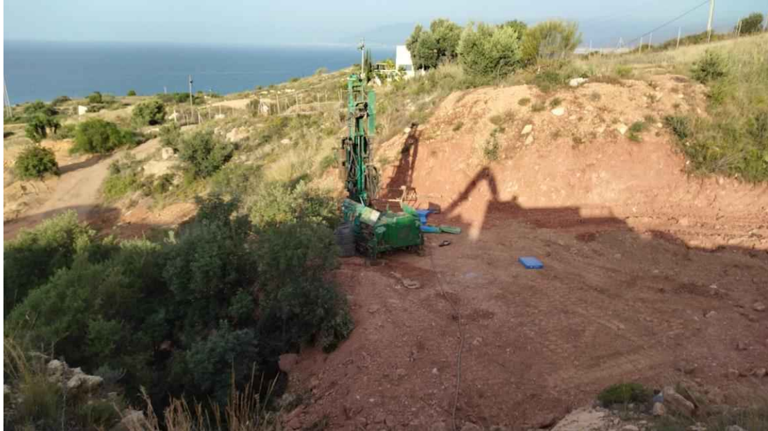
Realización de Sondeo 23.
