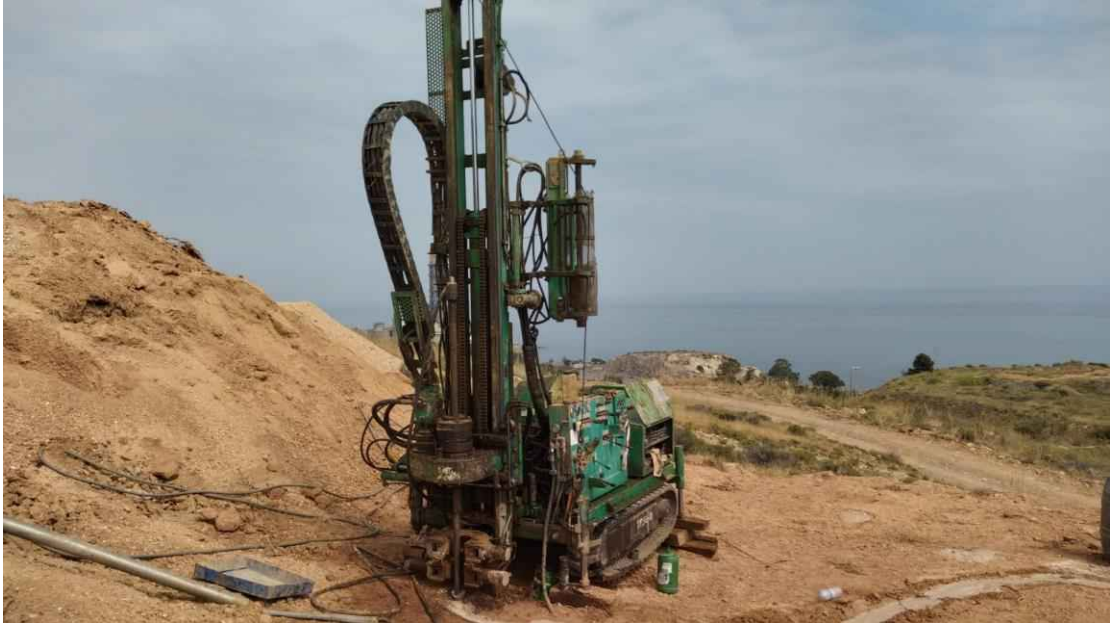
Realización de Sondeo 11.
