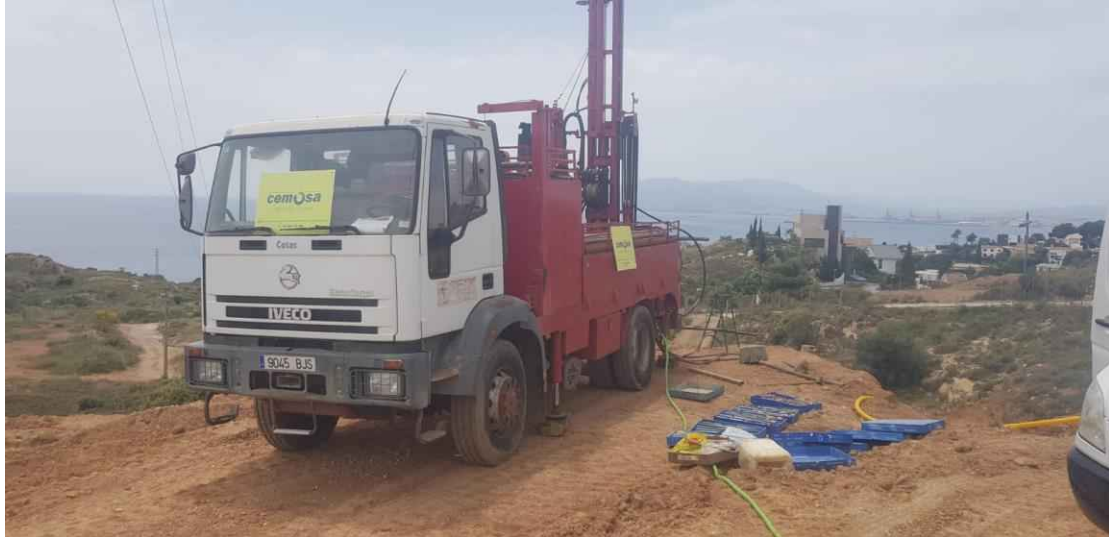
Realización de Sondeo 9.
