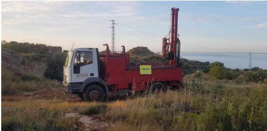
Fotografía Nº 20.- Emplazamiento del sondeo a rotación S-20.
