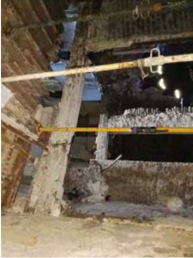
Apuntalado de elementos estructurales.
