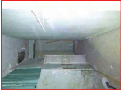
2. Demolición de particiones interiores.
