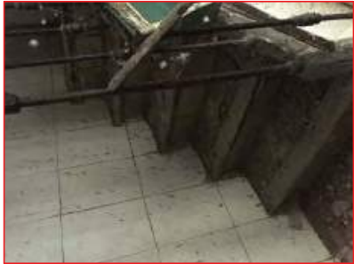
1. Demolición de la escalera.
