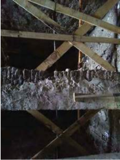
Apuntalado de muro de carga.
