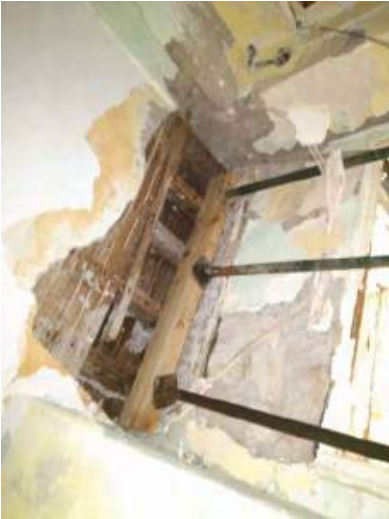
Apuntalado de elementos estructurales.
