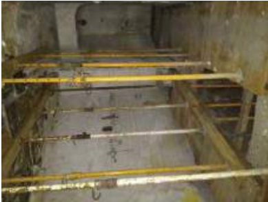
Apuntalado de elementos estructurales.
