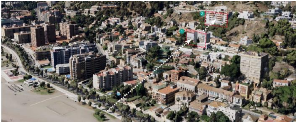
Imagen 3. Impacto de las vistas desde el paseo
