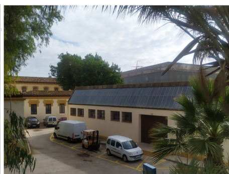
Fotografías del estado actual nave taller de mantenimiento
