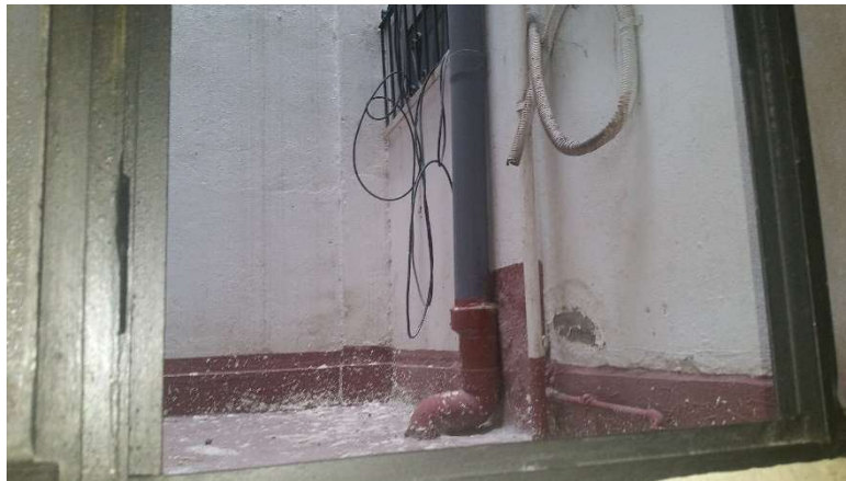
Patio interior, a nivel de planta primera.
