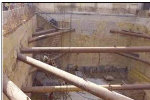
3.- Una vez llegado al punto inferior de excavación, se realizará la losa de cimentación, junto con los pilares de la planta inferior, comenzando a ejecutar a estructura de abajo a arriba.
