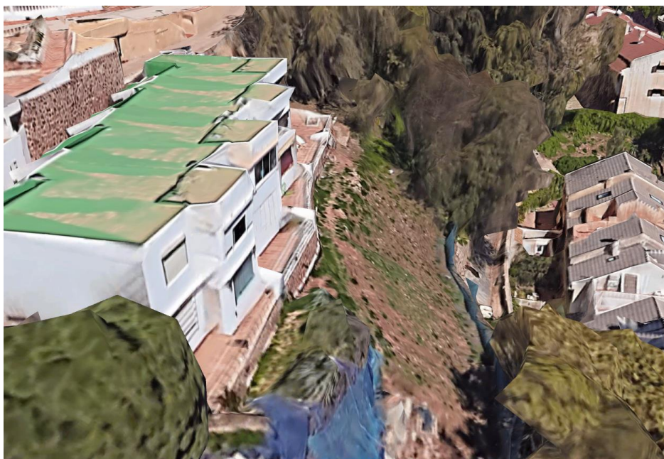
Imagen 4.- Visión de la pendiente y de las construcciones existentes linderas a la zona A B.- Oposición de los propietarios de construcciones colindantes existentes.
