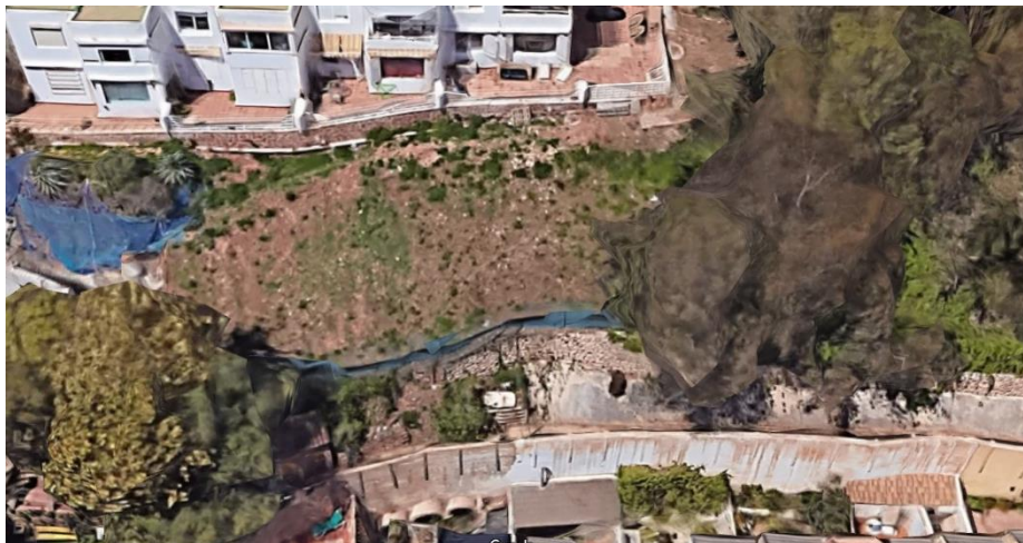
Imagen 3.- Visión del doble muro de contención, de piedra y pantalla
