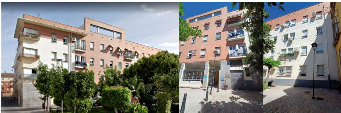
9 Fachada Norte de la Plaza de los Cristos, formada por bloque de viviendas tipo MC
