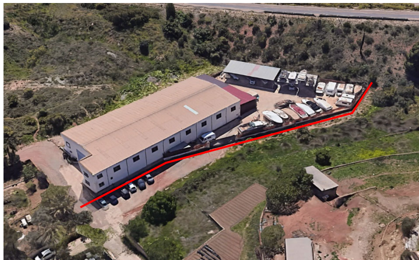
VISTA AEREA DE LA CONSTRUCCION INDUSTRIAL EXISTENTE FUERA DEL AMBITO DE LA UE4 PERI LE2
