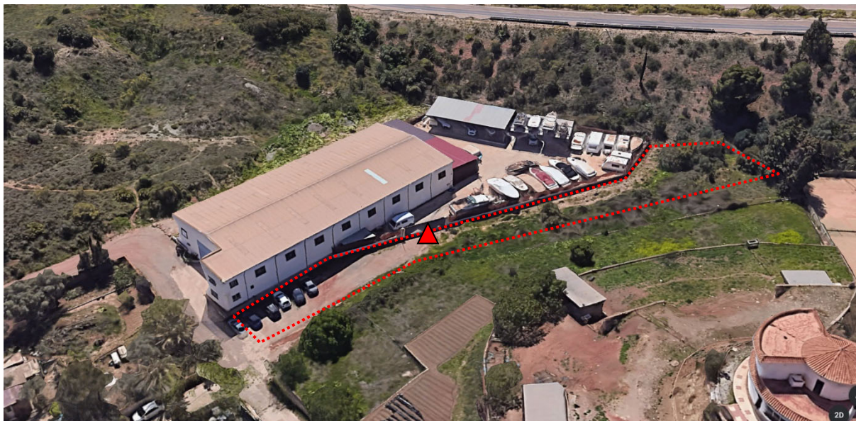
VISTA AEREA DE LAS PARCELAS DE SUELO INDUSTRIAL SEGREGADAS. EN ROJO LA ZONA DE AMPLIACIÓN PROPUESTA DE LA UE4 ASUMIENDO TODA LA PARCELA DE SUELO INDUSTRIAL SIN EDIFICACION. EN LA IMAGEN YA SE APRECIA COMO ESE SUELO ACTUALMENTE ESTA COINFIGURADO COMO ACCESO A LA PARTE TRASERA DE LA EDIFICACIÓN INDUSTRIAL.
