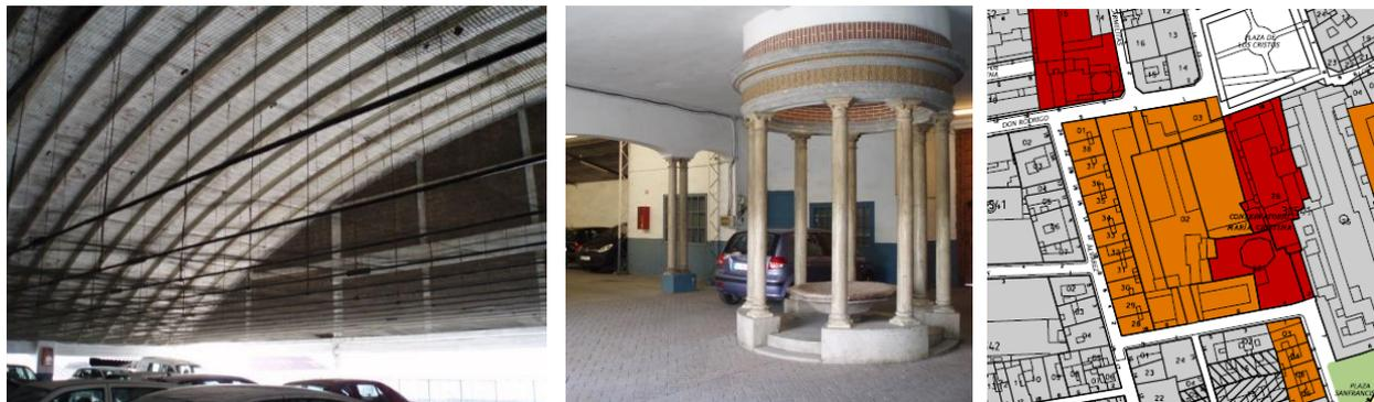
Fig 7. Bóveda nervada protegida con Arquitectura Grado I. Templete histórico a recuperar. Plano P.2.6 de Protecciones del PEPRi centro según PGOU vigente.
