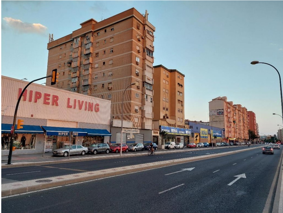
Linde NE: Estado actual de la Avda. Juan XXIII
