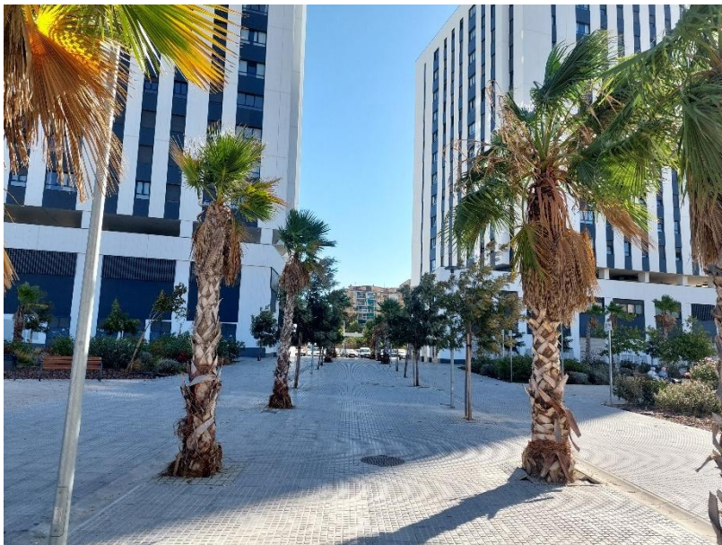
Estado actual de la prolongación de C. Sta. Justa en el ámbito de Sta. Rufina
