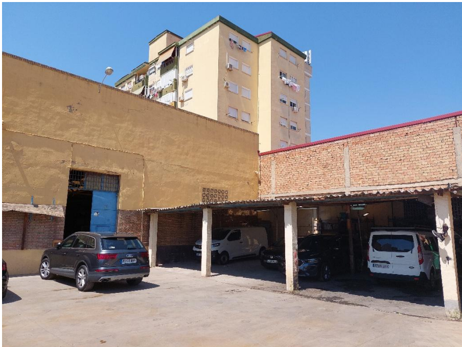
Medianera y edificación colindante al NO del ámbito
