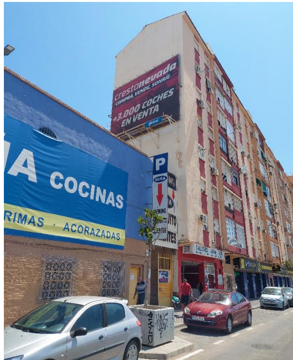
Medianera junto a Avda. Juan XXIII (a ocultar), y árbol afectado por las obras (Nótese el vallado publicitario en vuelo sobre la medianera, a retirar)
