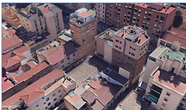
Fig. 05. Foto con la situación volumétrica actual del ámbito
