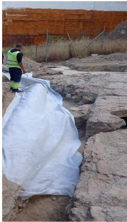
Tapamiento con geotextil
