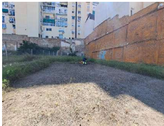
Desbroce y Limpieza
