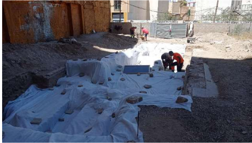
Tapamiento con geotextil
