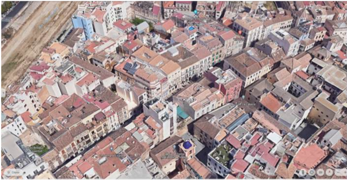
Alzado sur de tramo de calle Carretería, en el cual puede apreciarse la homogeneidad predominante de alturas
