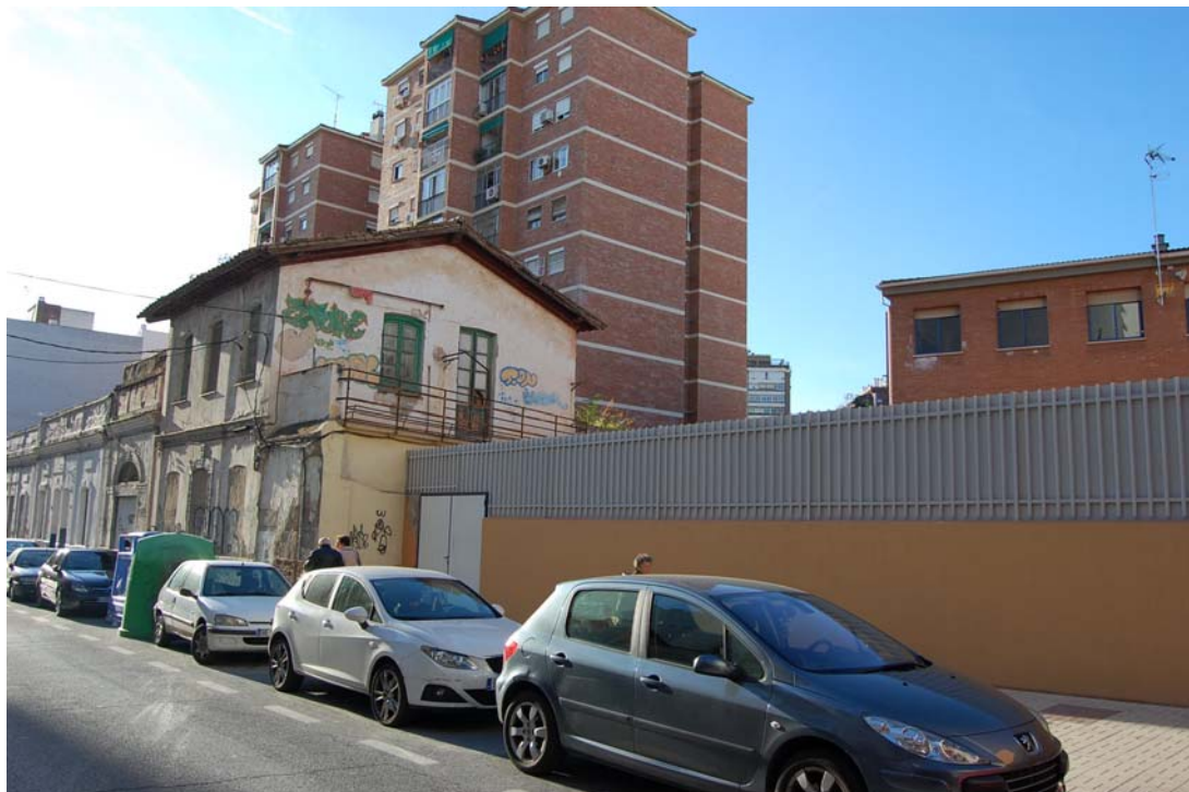
Fotografía 1. C/ Don Cristián nº 39 afectada. Vallado colegio (alineación PGOU)
