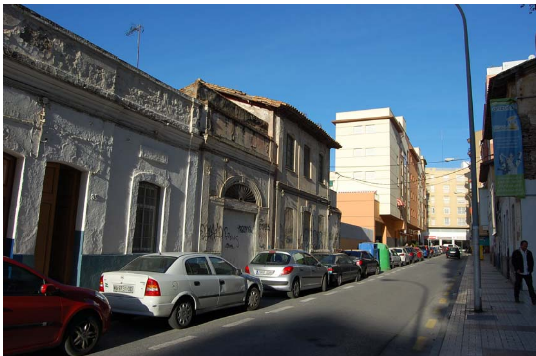
Fotografía 2. Vista de la zona afectada.
