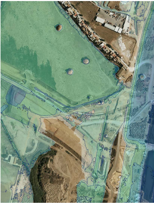
Ilustración 16. Movimiento de tierras en fase de obras, durante la realización del vuelo LIDAR, de base para el estudio hidráulico de la Consejería.
